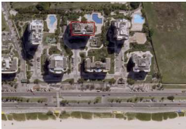
Figura 14: Localização do edifício Myrtle Beach Fonte: Autor
