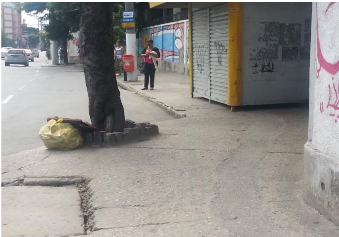
Figura 12: Rua Marquês de Paraná, nº303 – calçada do HUAP - Fonte: o autor.
