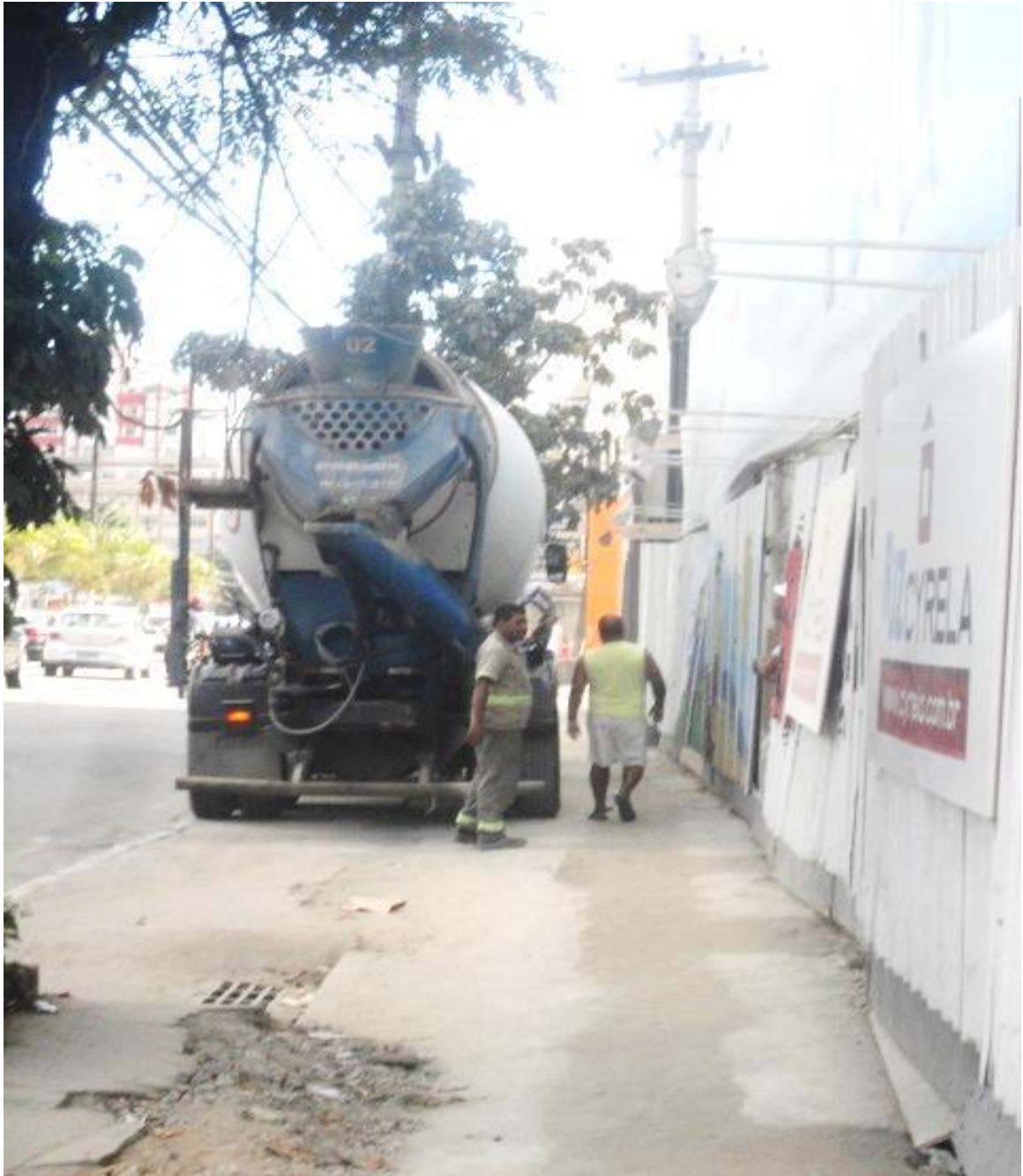
Figura 20: Rua Marquês de Paraná, nº349 - Fonte: o autor.
