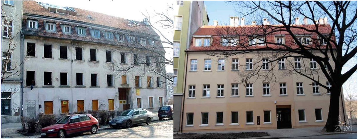
Figura 13 - Antes e depois de reabilitação de apartamentos para locação social no Centro Histórico de Wrocław (Księża Witolda st.45/47), Polônia (Fonte: CECODHAS, 2010).
