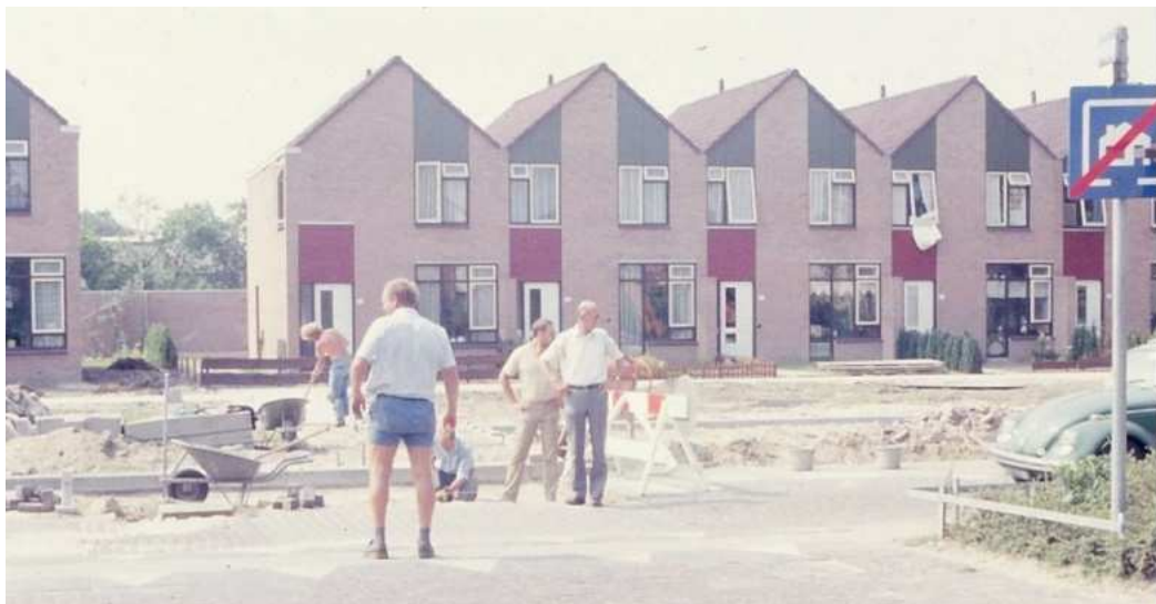
Figura 14: Sobrados geminados em construção (1970) no Conjunto Residencial de Wesselerbrink, Enschede-Zuid, Países Baixos (Fonte: STRAATBEELD, 2010).
