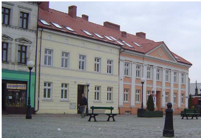
Figura 27 – Reabilitação de edificações antigas por TBS em Konin, com destaque para dispositivos de captação de energia solar (Fonte: ZANIEWSKA e BAREK, 2009)
