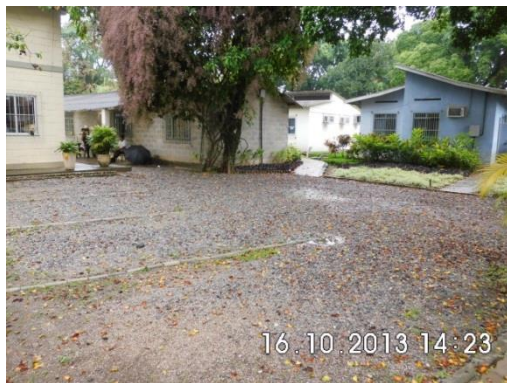
Ponto de Alagamento - 1
