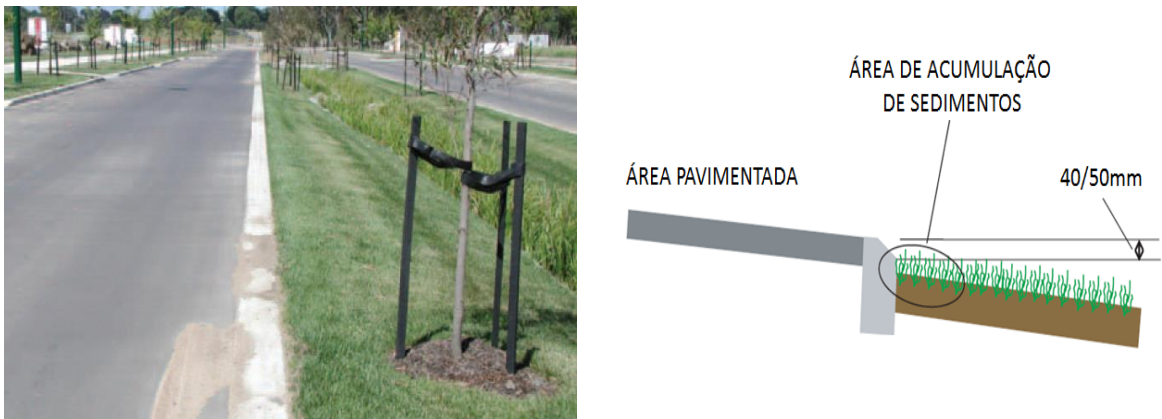
Figura 6: Acúmulo de sedimentos na rua e detalhe da borda mostrando o desnível recomendado
