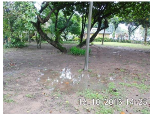
Ponto de Alagamento - 2
