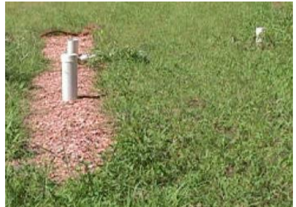
Figura 9: Esquema típico de trincheira de infiltração e foto
