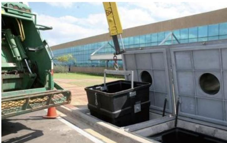
Figura 44 – Sistema de acondicionamento subterrâneo de lixo.
