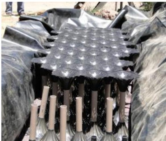
Figura 42 – Composições do reservatório permeável.
