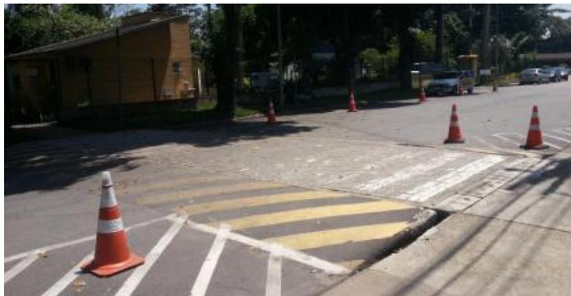
Figura 29 – *Speed Table* - Travessia de pedestres ao nível do passeio.
