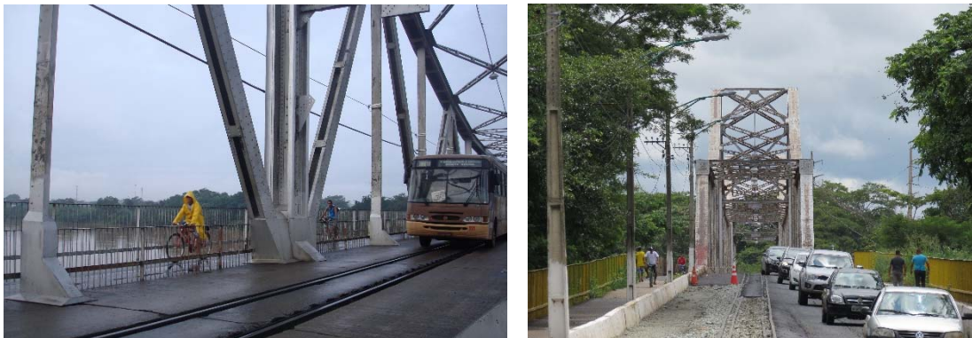
FIGURAS 55 e 56: Ponte Metálica
