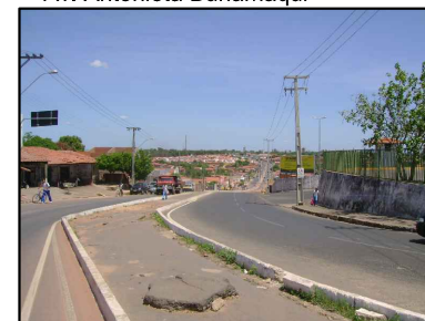
Av. Antonieta Burlamaqui
