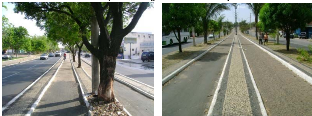
FIGURAS 64 e 65: Manutenção – Av. Miguel Rosa e Av. Henry Wall de Carvalho
