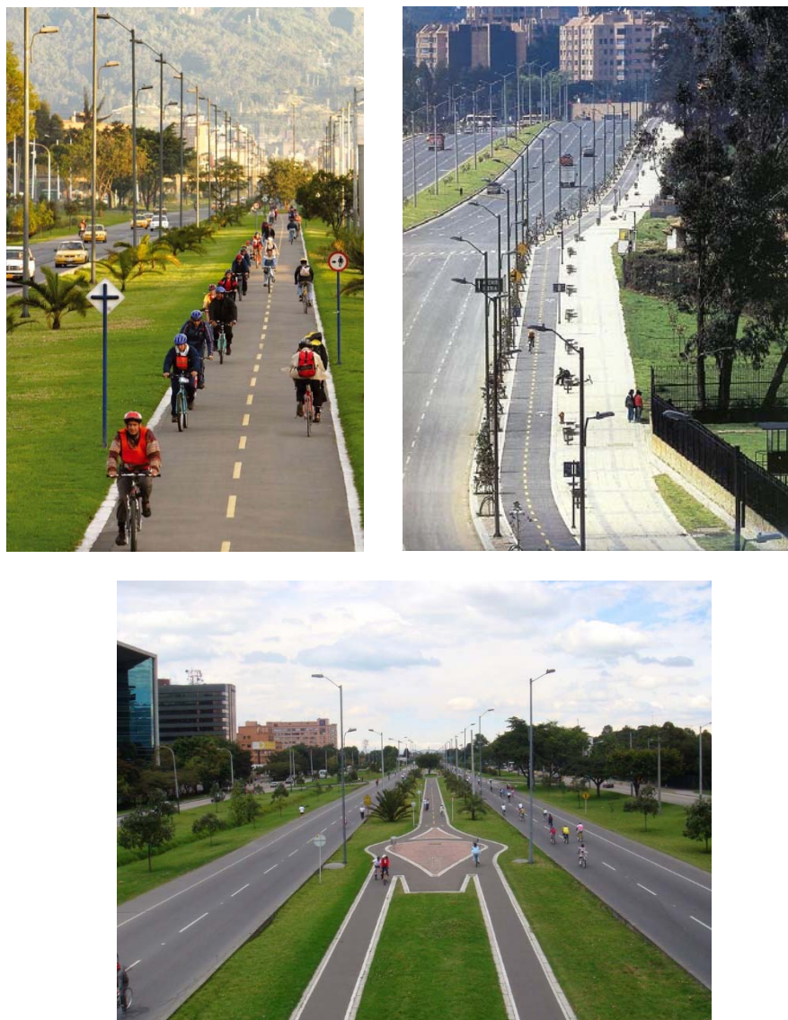
FIGURAS 36, 37 e 38: Ciclovias bidirecionais, projetadas com arborização e largos passeios pedonais paralelos
