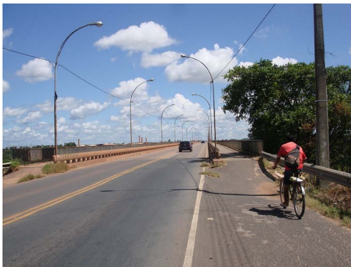
FIGURA 57: Ponte da Tabuleta, sentido Teresina &gt; Timon
