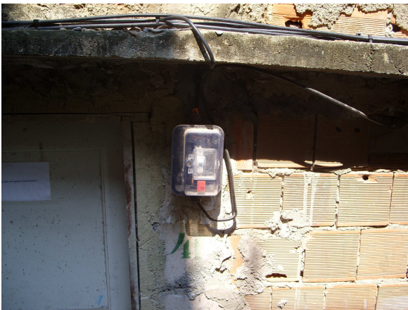
Figura 23 – Medidores de consumo de energia elétrica individuais.
