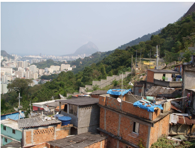
Figura 19 – Vista do limite lateral direito da Favela já com o muro divisório.
