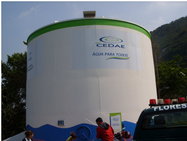
Figura 13 – Reservatório de água da CEDAE situado no parte superior da Favela.
