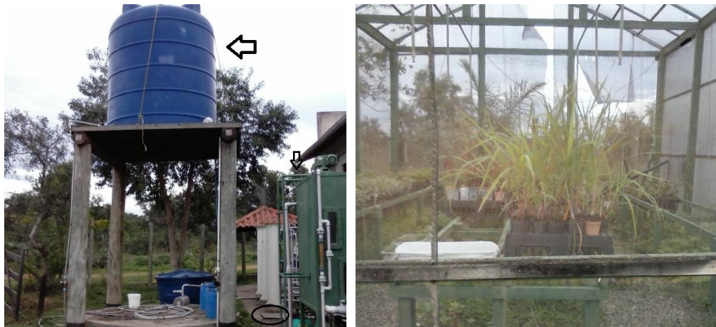
Figura 9 - Caixa d'água que recebe a água retirada do rio Paraíba do Sul e irrigação das plantas cultivadas no campus Rio Paraíba do Sul.
