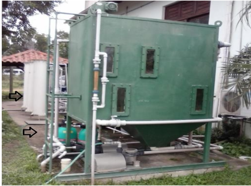
Figura 11 - Estação de tratamento de água (ETA) retirada do rio Paraíba do Sul no campus Rio Paraíba do Sul. Autora: Aline Oliveira (2015)
