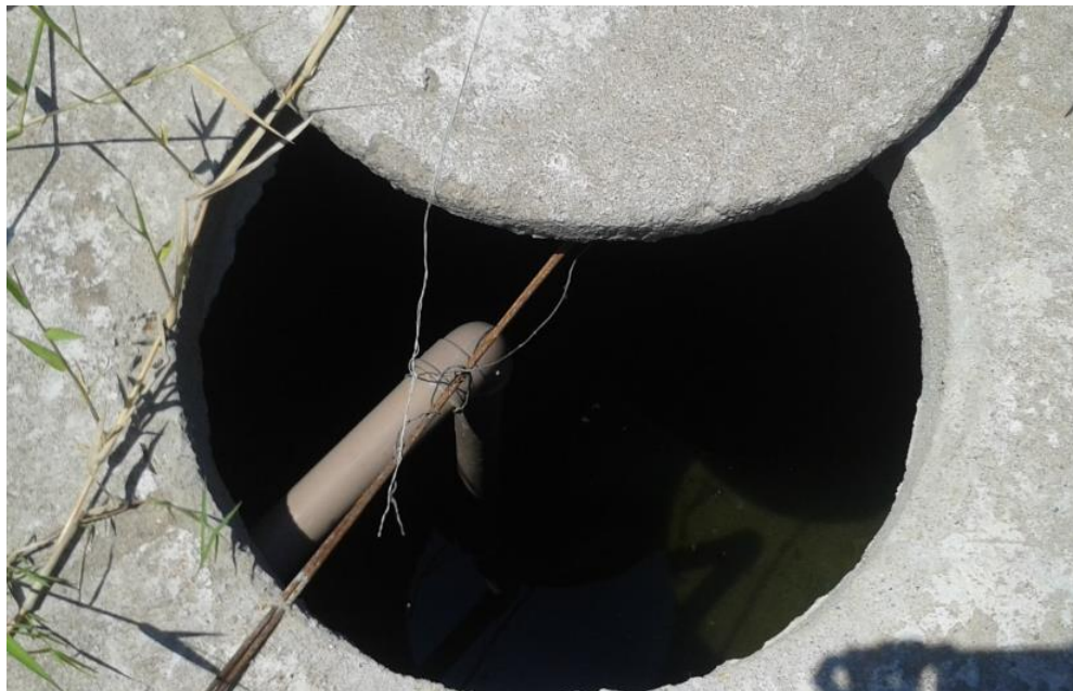
Figura 17 - Cisterna da coleta da água da chuva e dos ares condicionados para utilização na irrigação da área verde do campus Santo Antônio de Pádua. Autora: Rafaela Moraes Cruz (2016)
