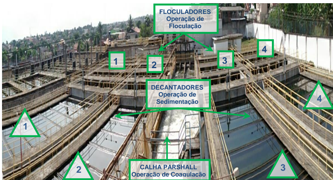
Figura 13: Unidades constituintes do processo coagulação, floculação, decantação da ETA nº 1
