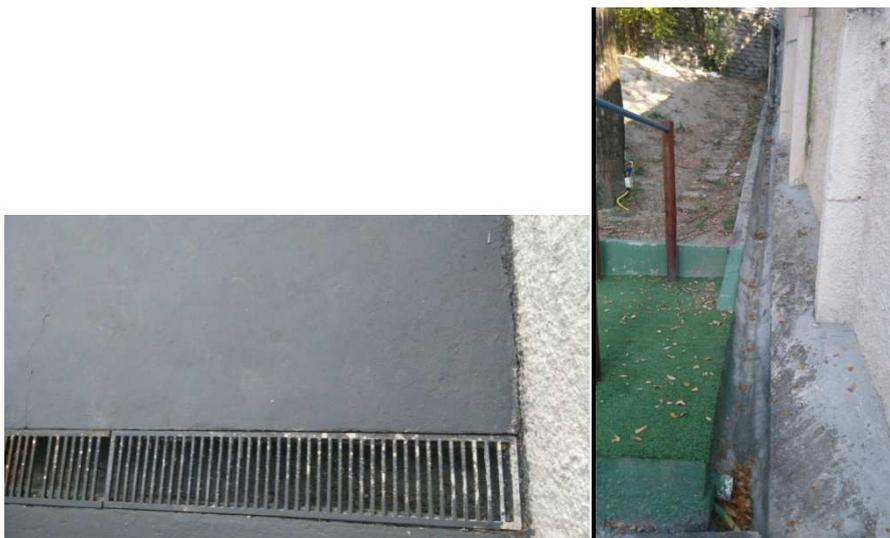
Figura 58 - Canaletas de escoamento de águas pluviais.
