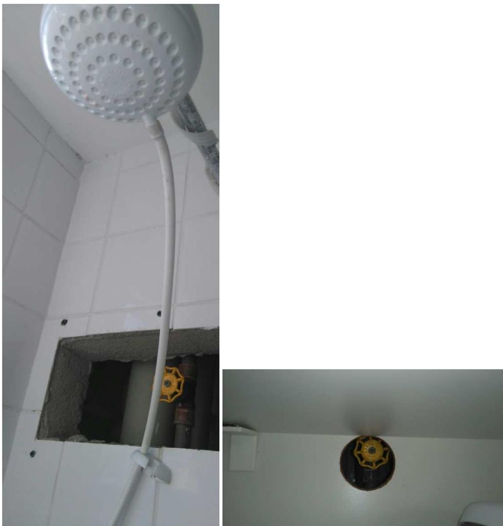
Figura 57 - Registros reguladores de vazão da cozinha e do banheiro.
