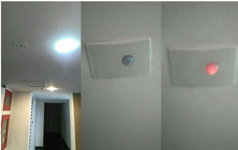
Figura 40 - Dispositivo economizador de energia elétrica para lâmpadas fluorescentes em áreas comuns.
