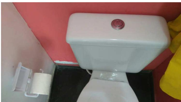
Figura 55 - Sanitário dotado de descarga com duplo acionamento.
