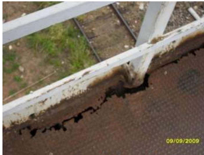
Figura 45: Passagem superior em estado inadequado de conservação
