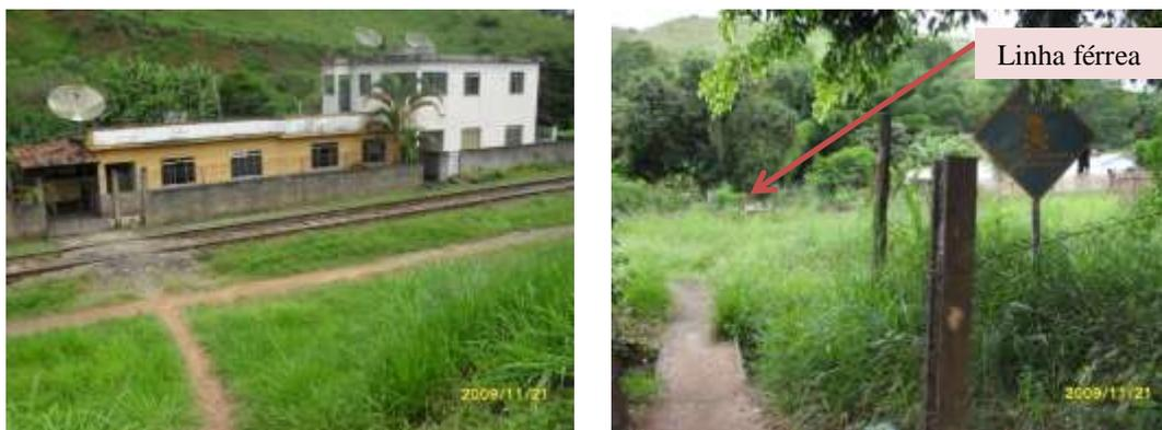
Figura 49 (a) e (b): Passagens de nível avaliadas (sem pavimentação e sinalização)
