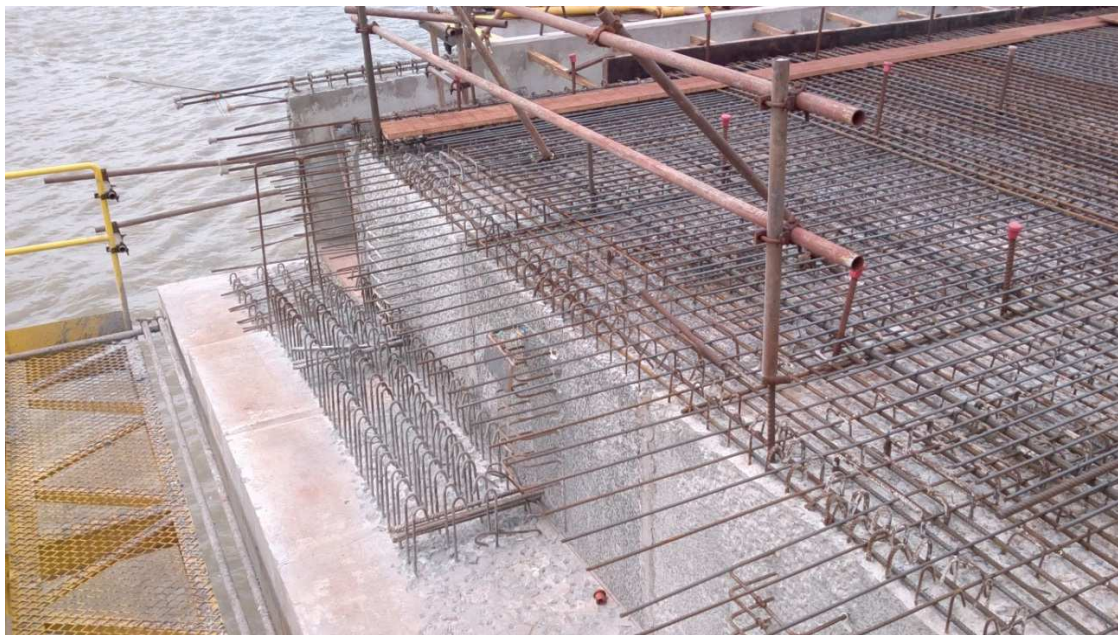
Figura 4-6 – Posicionamento das vigas pré-moldadas sobre os blocos já consolidados e distribuição da armadura da laje para concretagem.
