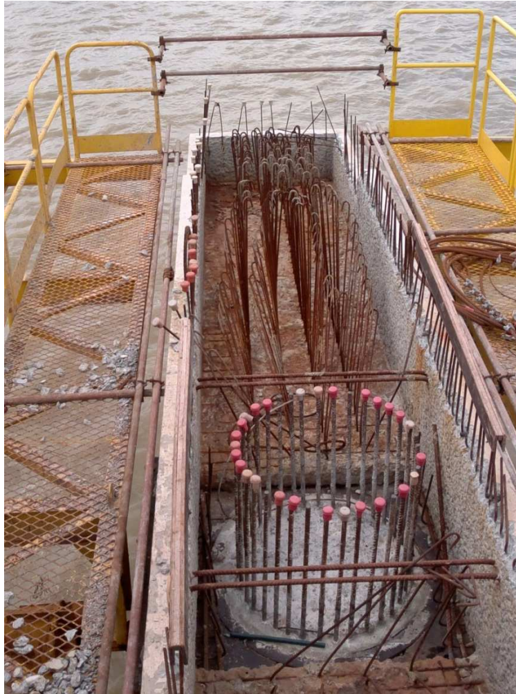
Figura 4-5– Posicionamento dos Blocos Pré-Moldados sobre as Estacas.
