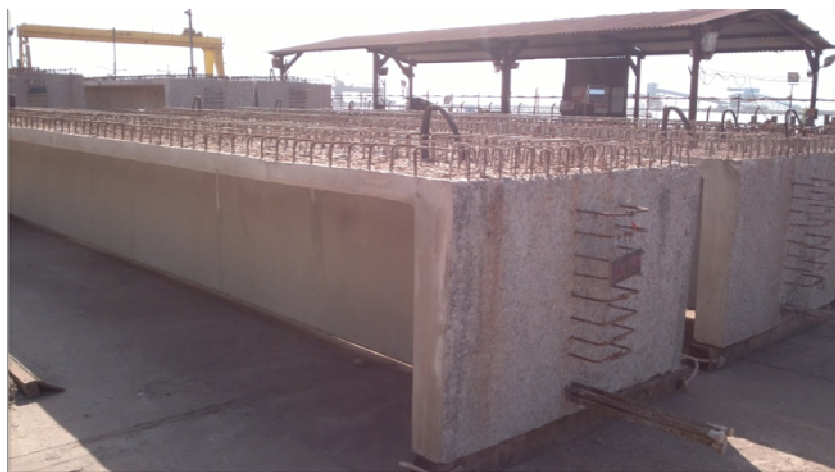
Figura 4-4– Viga T pré-moldada no canteiro de pré-moldados (local de fabricação e armazenamento).
