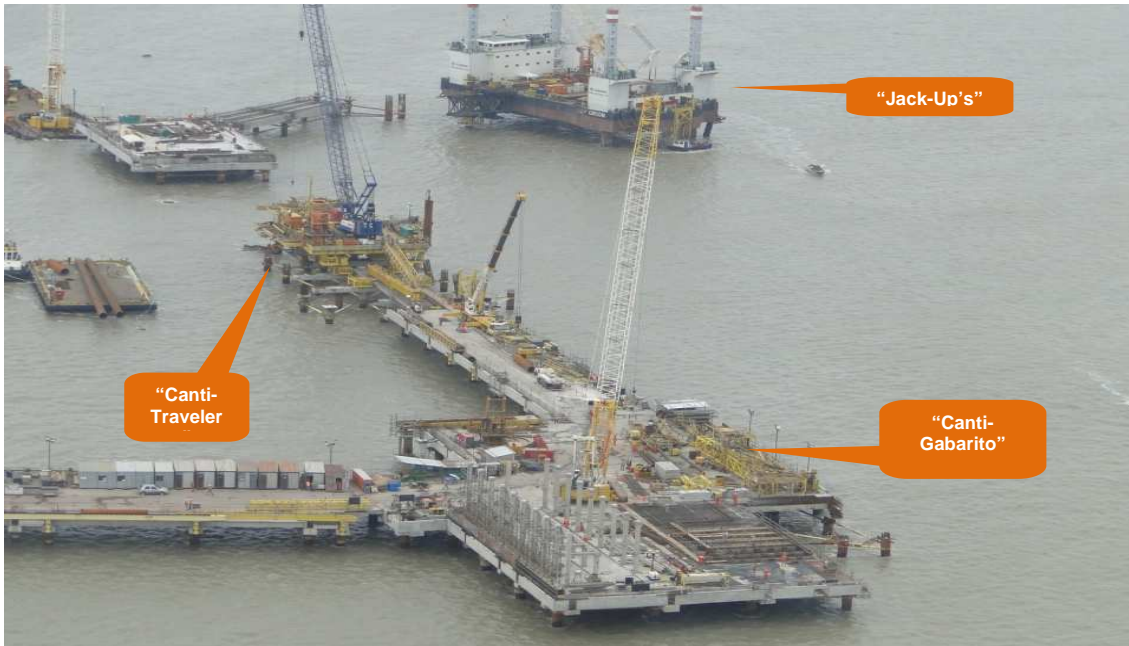
Figura 3-6– Foto Aérea da Obra em 2011 – Metodologias Executivas.
