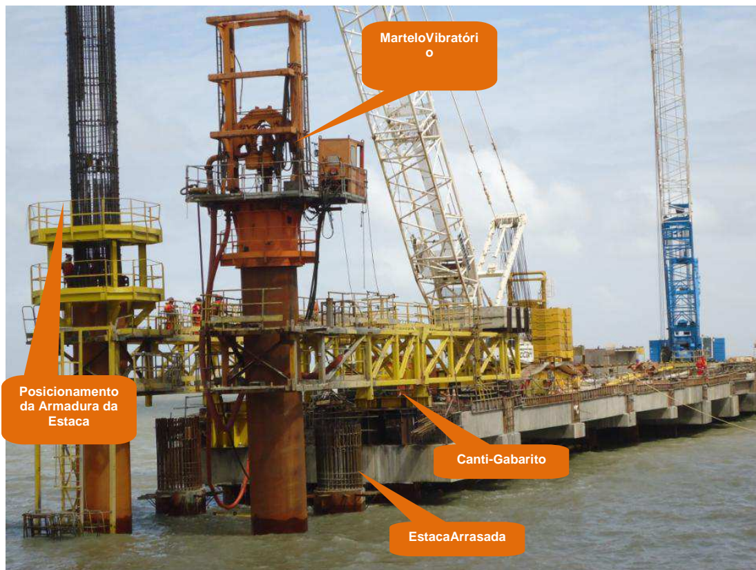
Figura 4-17– Execução de Estacas D7 e D8.
