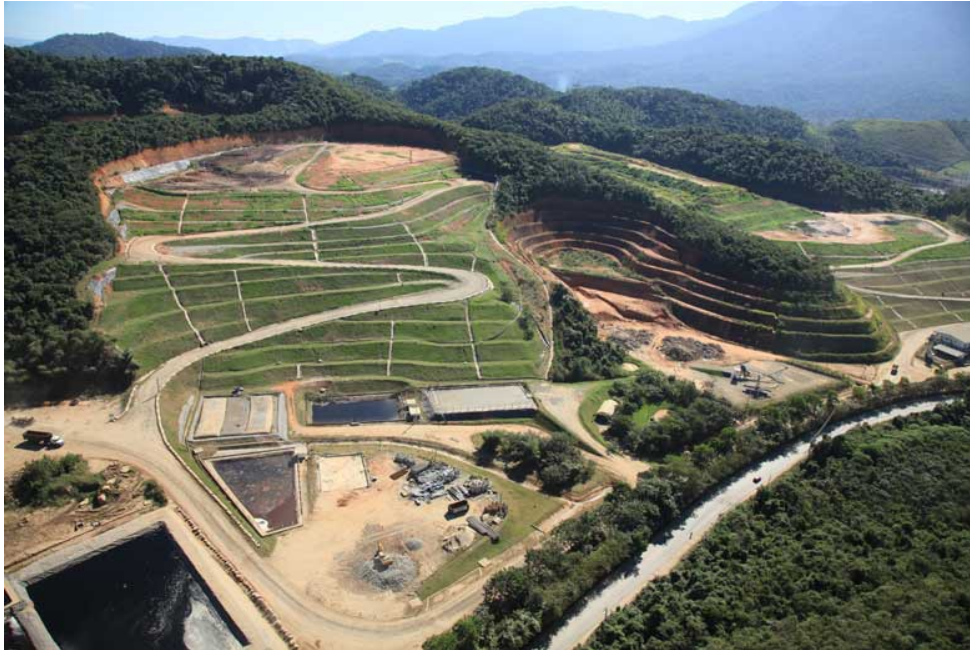
Figura29 - Central de Tratamento de Resíduos – Adrianópolis/Nova Iguaçu
