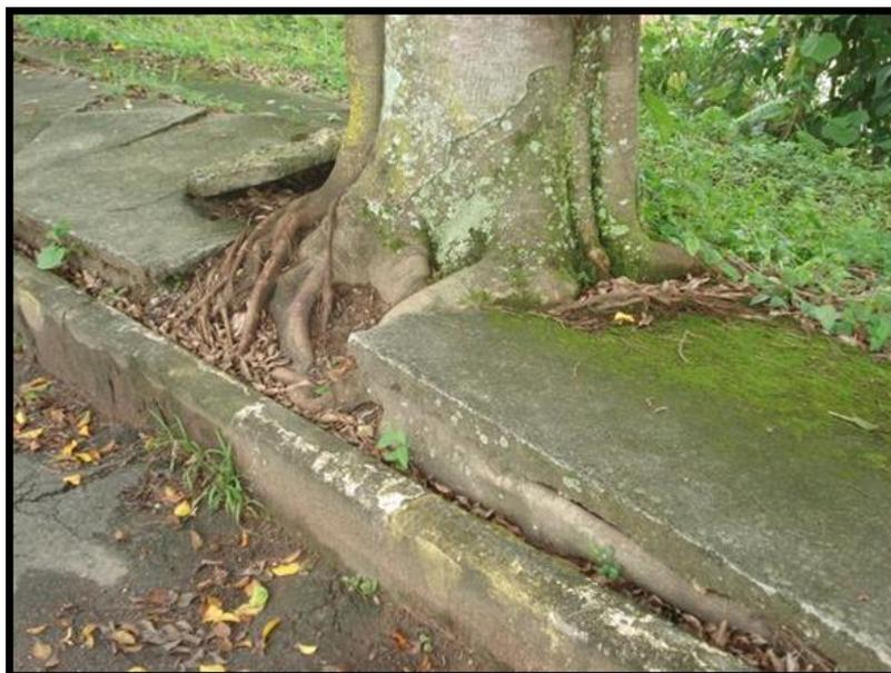
Figura 32 – Detalhe da junção tronco/solo de árvore do Gênero *Ficus* sp em calçada.
