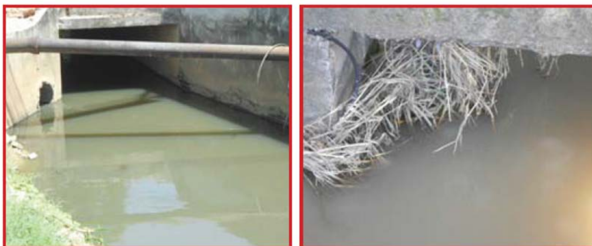
Figura 46: Exemplo de obstrução e estrangulamento no rio Botas. Fonte: CREA-RJ, 2013.
