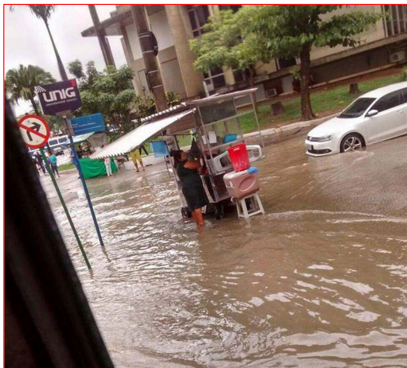
Figura 61: PONTO 4 - Rua Dr. Ataíde Pimenta de Moraes em frente à Prefeitura afetada pelo alagamento no Centro de Nova Iguaçu-RJ. Fonte: www.noticiasdabaixada.com.br (acessado em março/2016)
