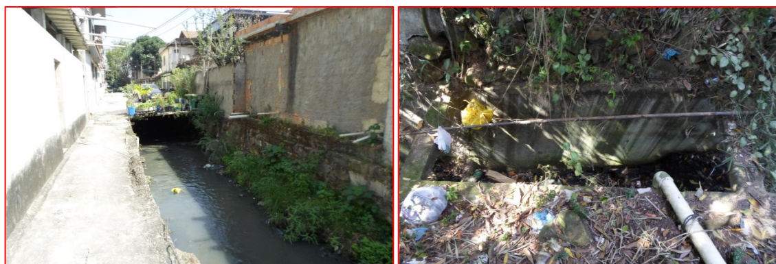
Figura 56: Lançamentos de efluentes (esgoto residencial) no rio Machambomba. Fonte: Acervo do autor, 2014.
