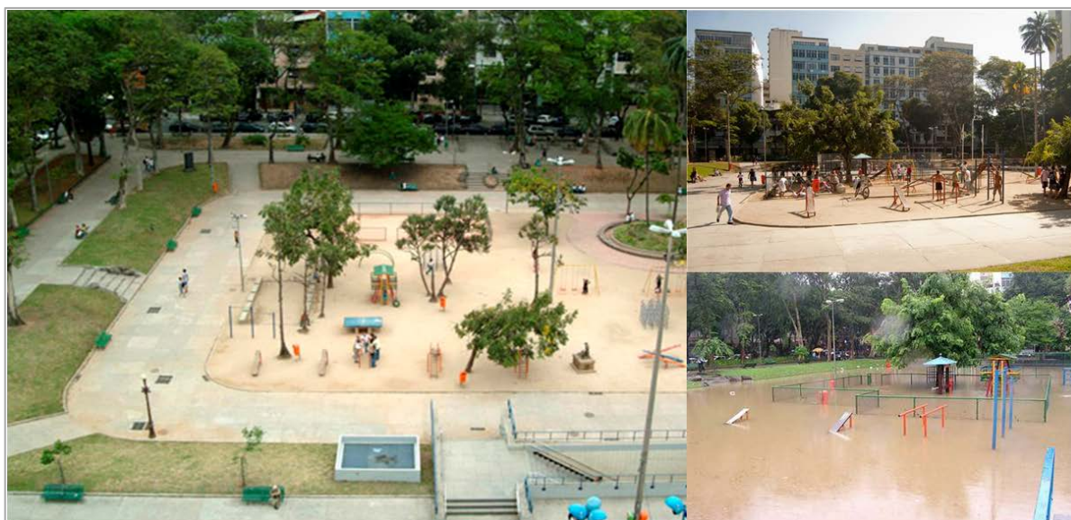
Figura 37: Exemplo de reservatório de detenção a céu aberto | Praça Afonso Pena | Rio de Janeiro | RJ Fonte: Prefeitura do Rio de Janeiro, 2015.
