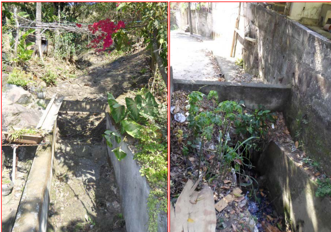
Figura 53: PONTO 1 - Canalização próxima à nascente do rio Machambomba. Fonte: Acervo do autor, 2014.
