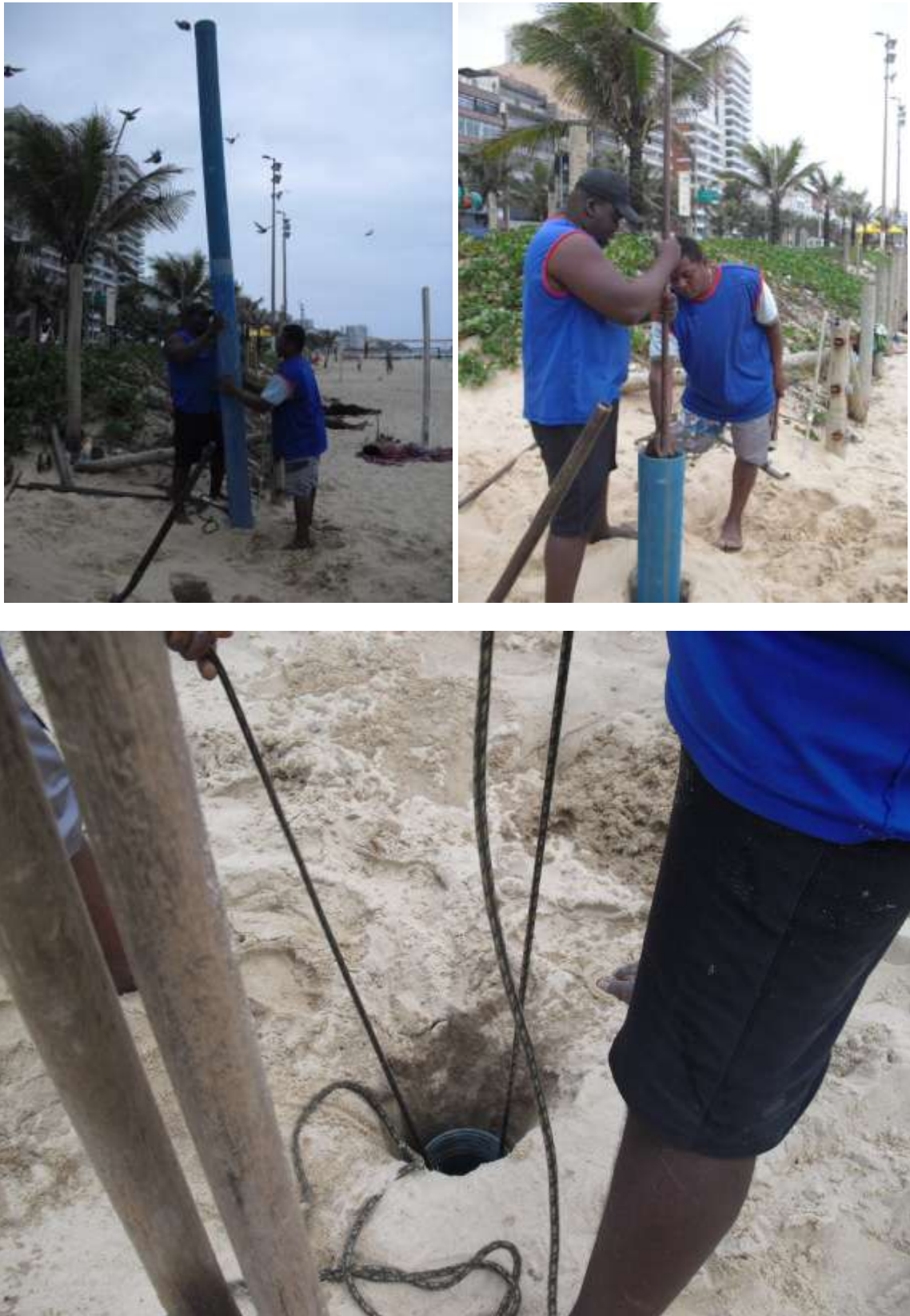
Figura 5.61: Introdução do filtro geomecânico e a continuação do processo de furação. Fonte: arquivo pessoal, 2011.
