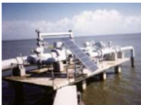
Figura 3.33: Proteção da tubulação no setor de óleo e gás. Fonte: Kyocera, 2010.
