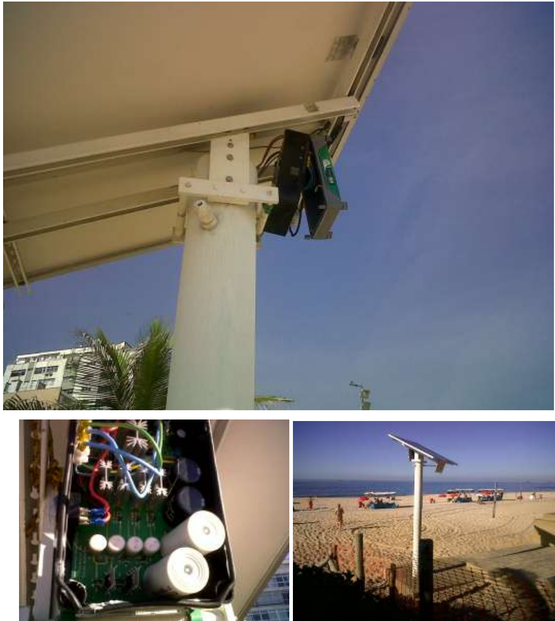
Figura 5.70: Vandalismo praticado na Ecoducha, furto da ducha, torneira e abertura do driver da bomba. Fonte: arquivo pessoal, 2011.
