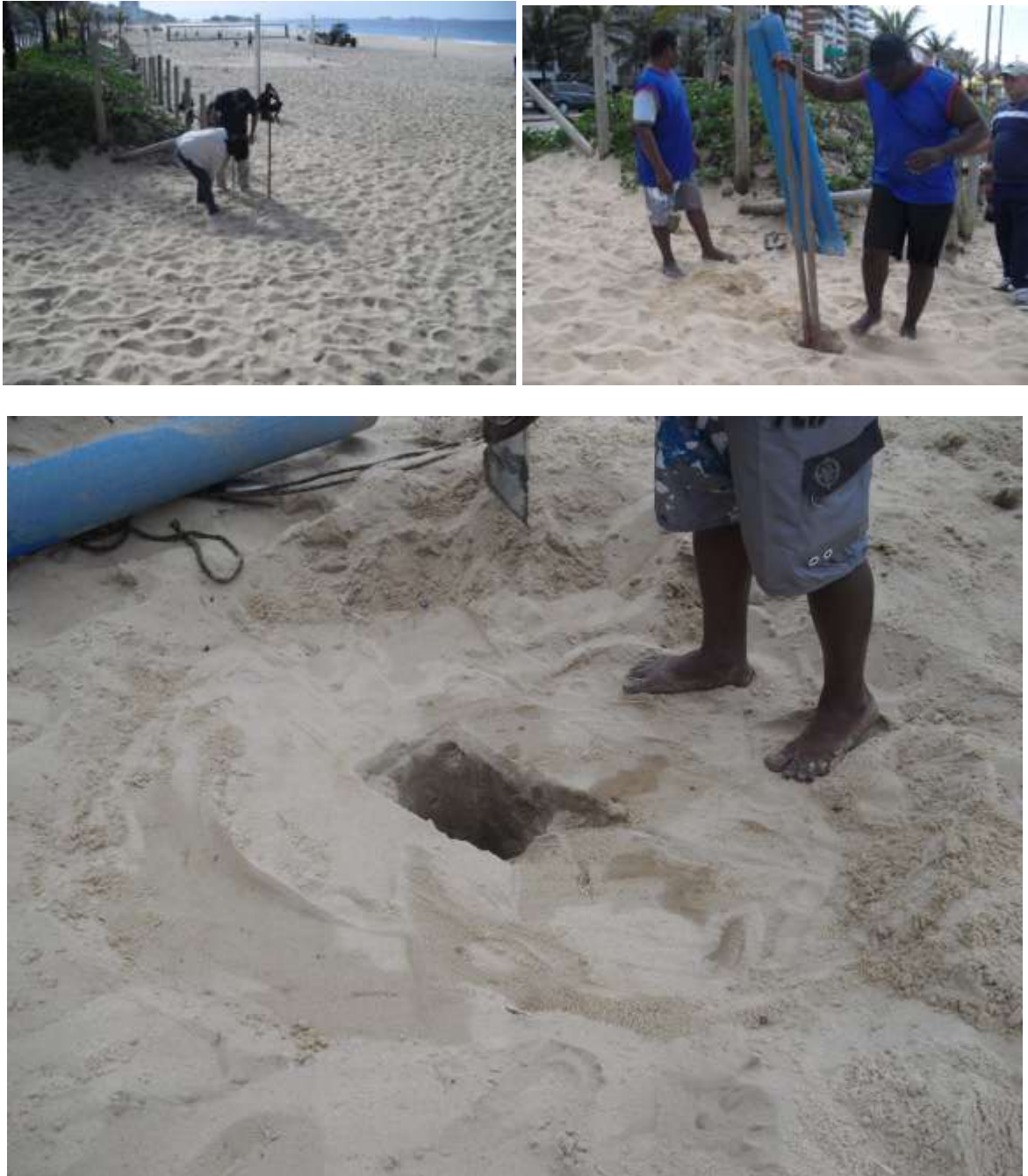
Figura 5.60: Escolha da furação do poço e o início da furação respectivamente. Fonte: arquivo pessoal, 2011.
