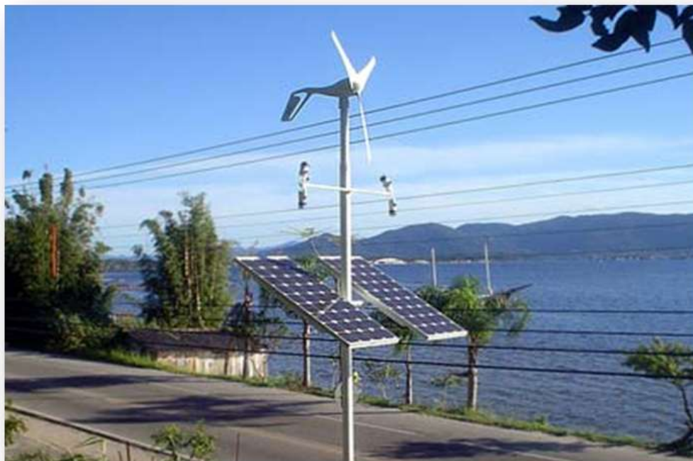
Figura 23: Exemplo de um sistema híbrido, eólico e solar. Fonte: Google, 2012.
