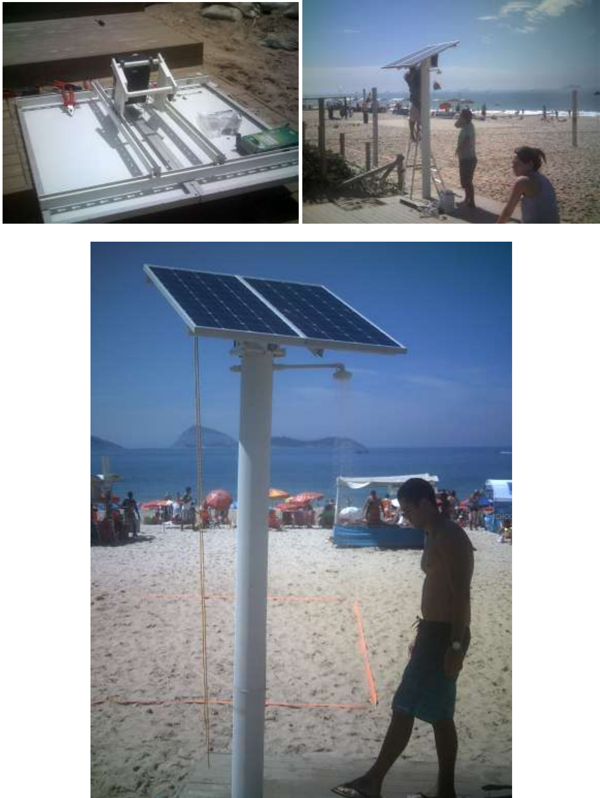
Figura5.66: Acabamento e instalação da estrutura de alumínio e teste do sistema. Fonte: Arquivo pessoal, 2011.
