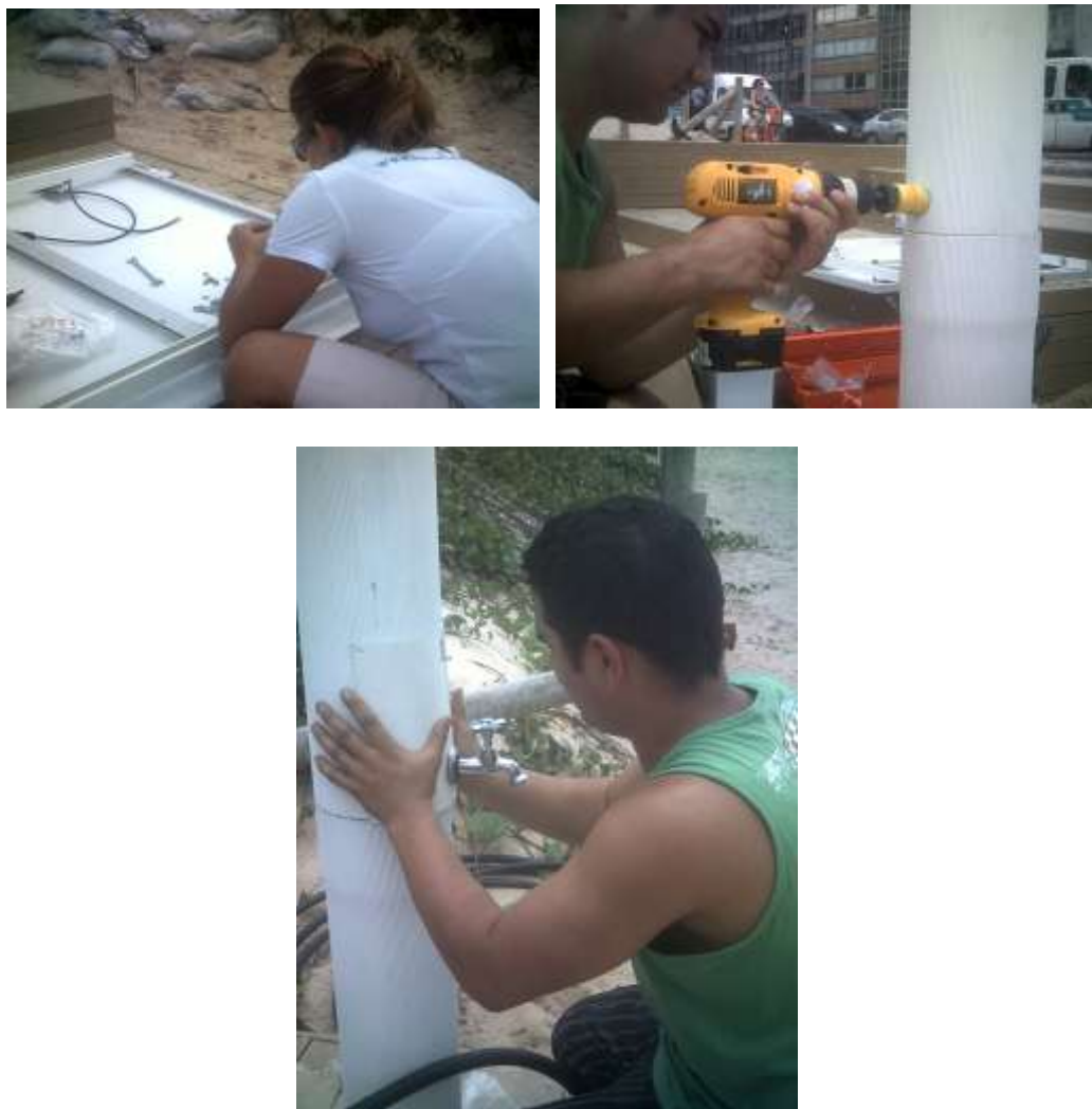
Figura 5.65: Instalação e colocação da torneira e da ducha. Fonte: arquivo pessoal, 2011.
