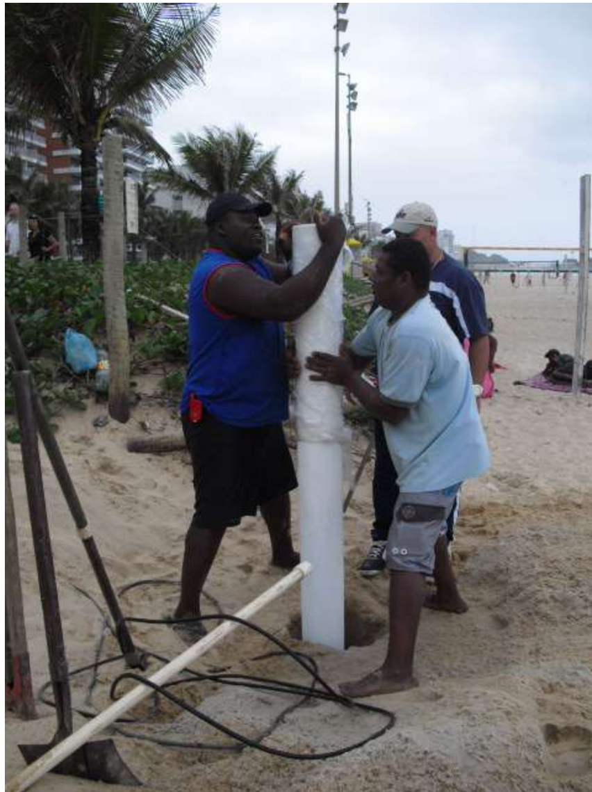
Figura 5.62: Continuação da furação do poço e a introdução dos outros tubos. Fonte: arquivo pessoal, 2011.
