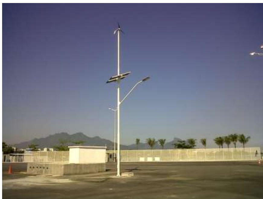
Figura 3.31: Poste solar e eólico – Greenpower – Cidade do Rock, Rio de Janeiro. Fonte: arquivo pessoal, 2012
