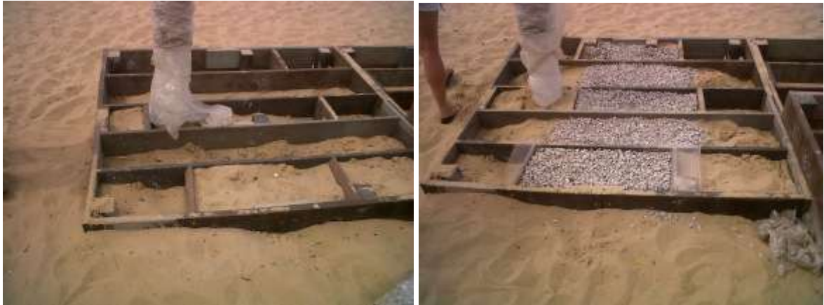
Figura 5.64: Finalização da instalação do tubo e a colocação de brita e uma tela para evitar empocamento de água para auxiliar na drenagem. Fonte: arquivo pessoal, 2011.
