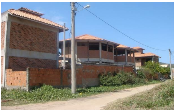
Figura 24 - Hotel embargado há pelo menos 5 anos, obra irregular no Bairro Miguel Couto. Fonte: a autora (2015).
