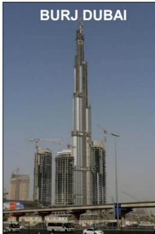
**Figura 14:** Torre Burj Dubai construída com Concreto de Alto Desempenho CAD 80 MPa, com emissões de 5kg por MPa. Fonte: Mehta, P.K.; ACI Concrete International, Fevereiro/2009 Otimização das Estruturas de Concreto Armado.
