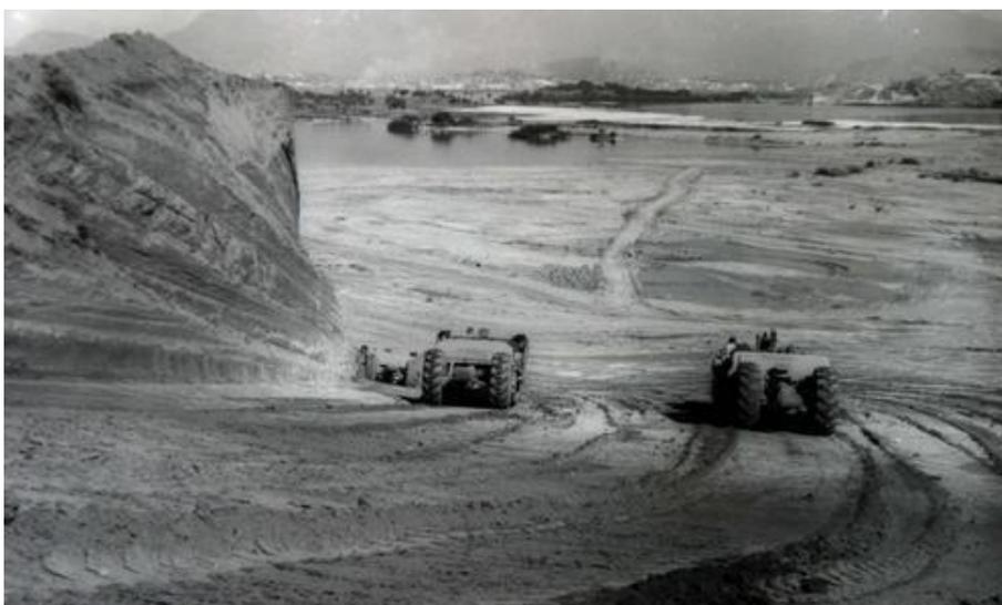
**Figura 19:** Foto antiga durante o aterramento observa-se o nivelamento, mas a Ilha do Catalão no centro superior com sua vegetação preservada. Fonte: <http://www.rioquepassou.com.br/2006/10/10>
