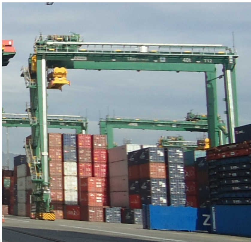
Figura 40 - Equipamento de Movimentação de contêiner –Transtêiner.
