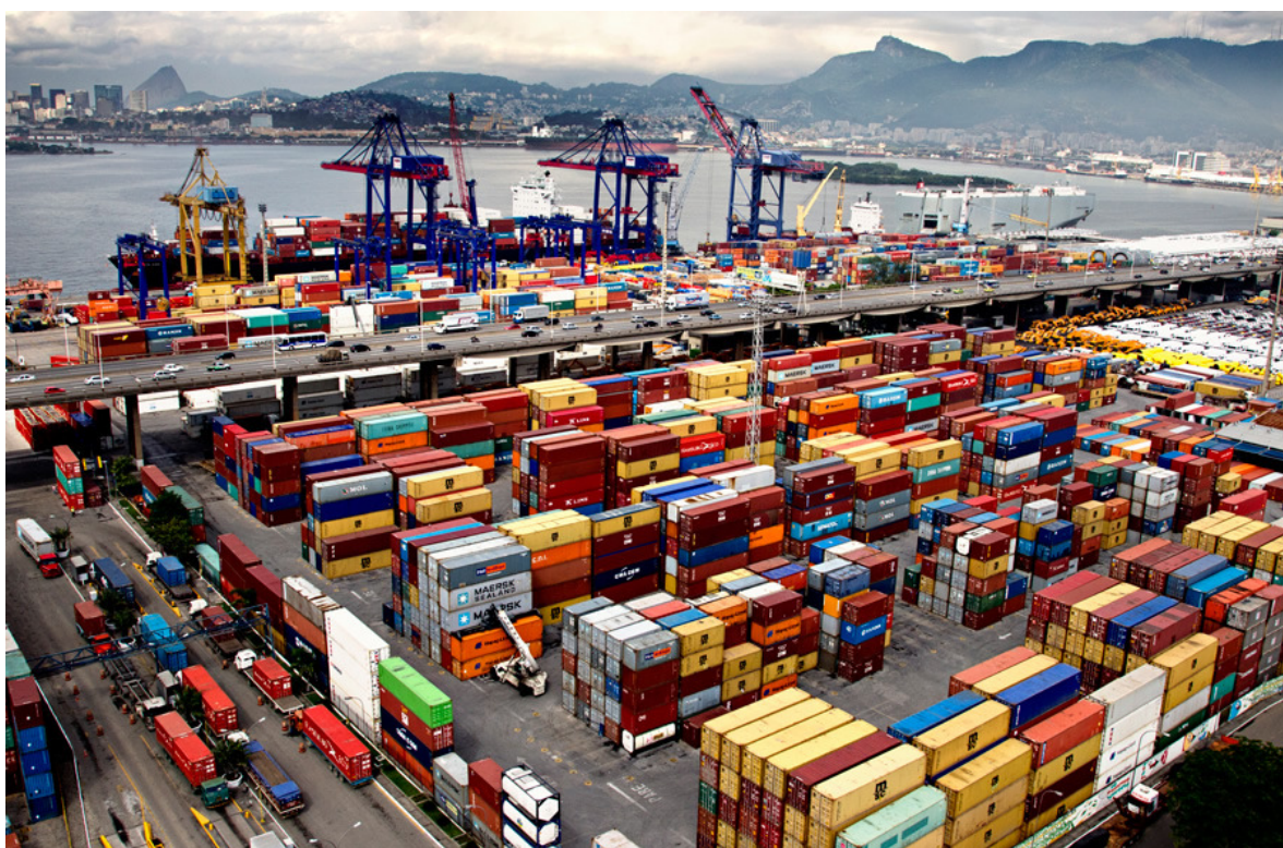
Figura 22 – Terminal de Contêineres MultiRio
