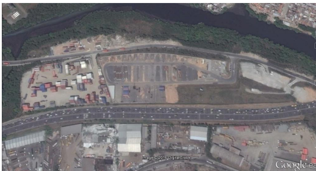
Figura 45 – Ampliação do terreno na lateral da via expressa da Linha Vermelha em 2015, totalmente ocupado por contêineres.
