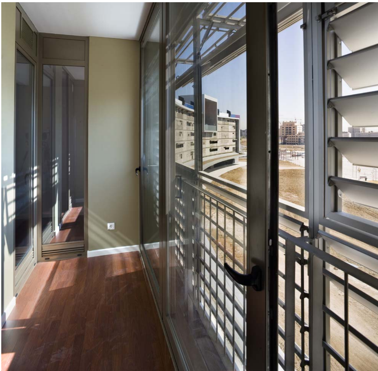
Figura 28 – interior de ambiente localizado na fachada sul, exibindo o corredor entre a lâmina de vidro e os brises soleil. Fonte: Ruiz Larrea e Associados, 2010.
