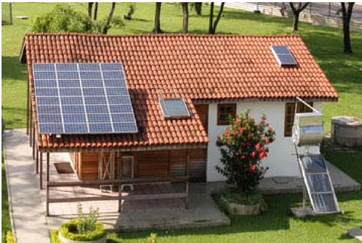
Figura 10: Casa Solar Eficiente, do Centro de Referência para Energia Solar e Eólica Sérgio de Salvo Brito – CRESESB, utilizada para pesquisas energéticas. Apresenta a utilização de energia solar térmica e fotovoltaica, assim como técnicas de combate aos desperdício energético. – Fonte: CRESESB, 2012.
