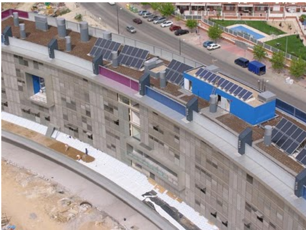
Figura 35– Painéis fotovoltaicos sobre cobertura. Fonte: Ruiz Larrea e Associados, 2010.
