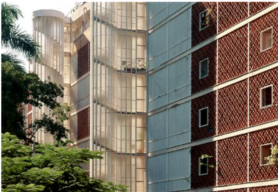
Figura 15 – Edifícios Nova Cintra, Bristol e Caledônia, 1954 – detalhe dos brises-soleils das fachadas, Parque Guinle, Rio de Janeiro (Arquiteto: Lúcio Costa). Fonte: Nelson Kon.
