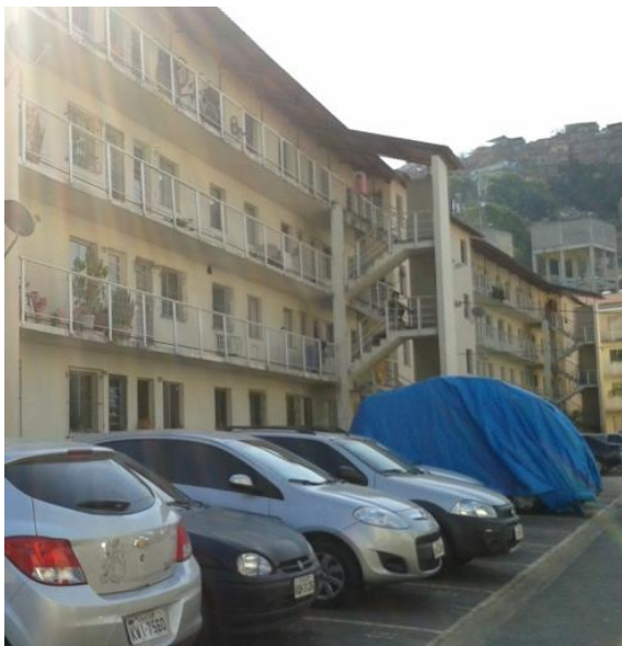
Figura 12 – Estacionamento no condomínio Mangueira II Fonte: acervo pessoal da autora (2015)
