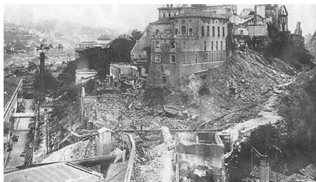
Figura 4 - Avenida Central e o morro do Castelo à esquerda da via.
