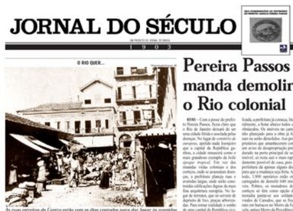
Figura 1 – Jornal do Século - imagem da demolição do cortiço no Centro do RJ
