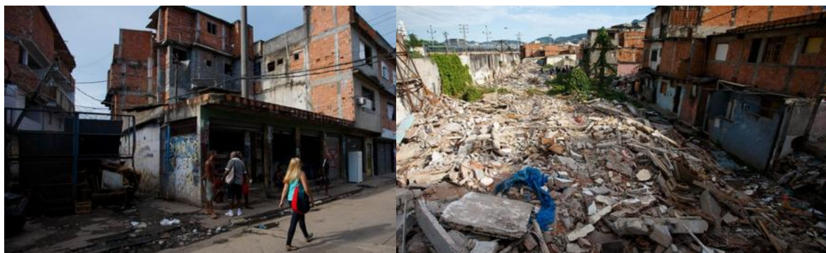
Figura 8 - Favela-Metrô-Mangueira antes e durante as remoções Fonte: http://noticias.bol.uol.com.br . Acesso em: abril de 2015.
