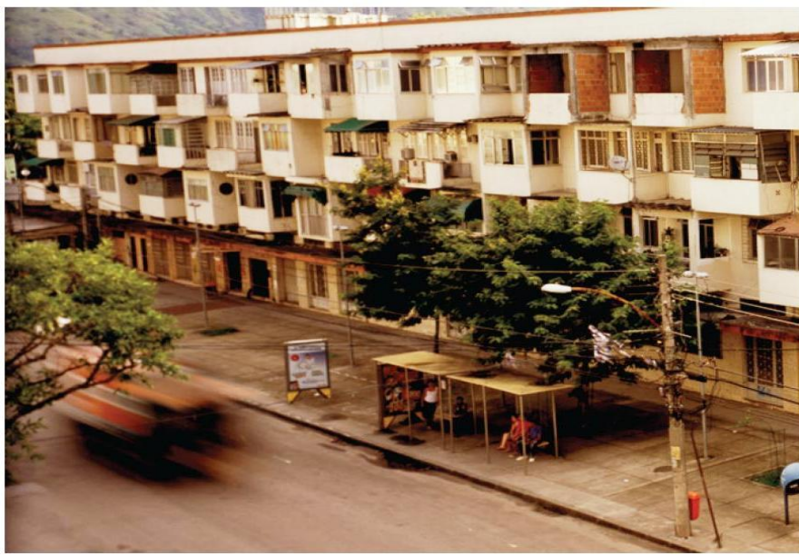
Figura 8 - Conjunto residencial do IAPI no bairro de Realengo – RJ 1938 Arquiteto: Carlos Frederico Ferreira. Fonte: BRUNA, 2015
