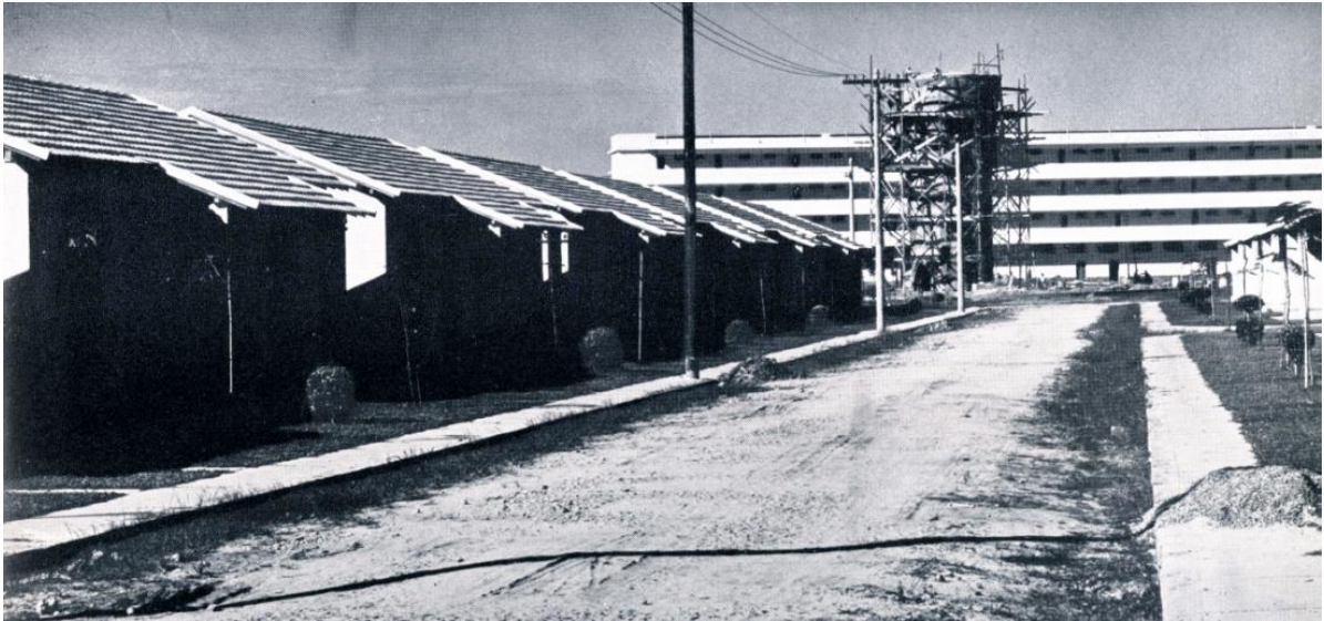
Figura 18 - Conjunto Realengo - Casas isoladas. Fonte: BOTAS, 2010.
