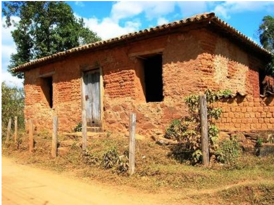
Figura 42 - Casa de terra – Bichinho – MG. Fonte: foto da autora, 2006
