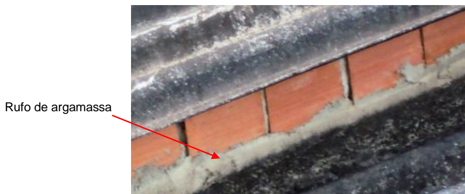
Figura 49 - Rufo de argamassa como arremate de telhado. Fonte: foto da autora, 2015
