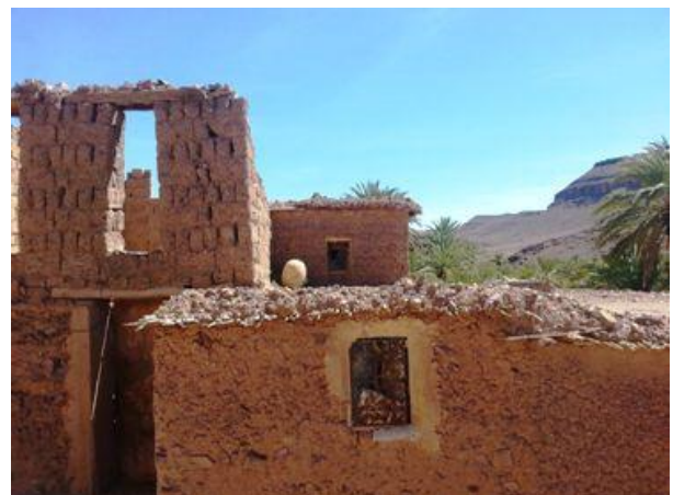
Figura 36 - Construção com terra Hadou, Marrocos. Fonte: foto de Leonardo Fragozo, 2016.
