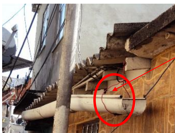
Figura 50 - Calha instalada na autoconstrução Fonte: foto da autora, 2015.
