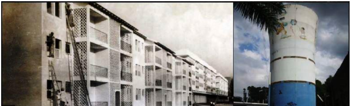
Figura 17 - Varandas com cobogós para ventilação e castelo d'água. Fonte: TRIGO, 2013
