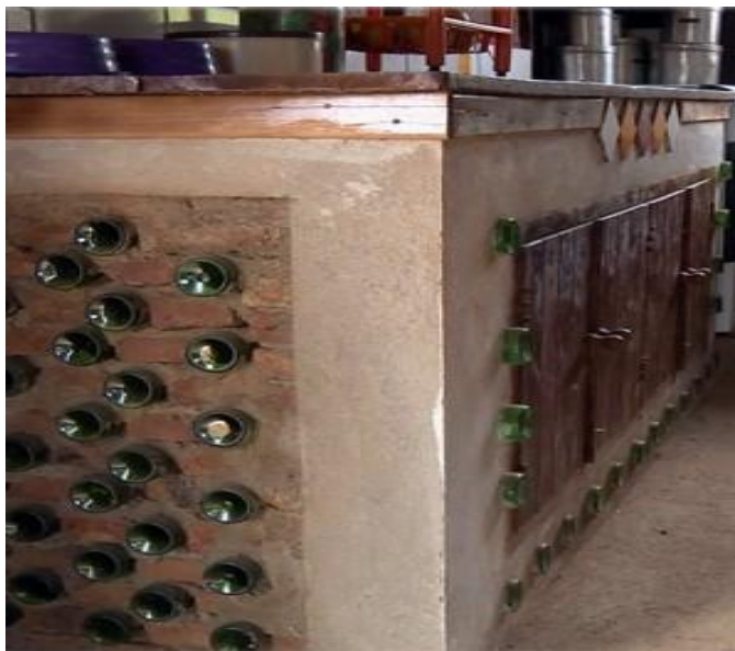
Figura 55 - Interior da casa de garrafas PET executada por pedreiro
