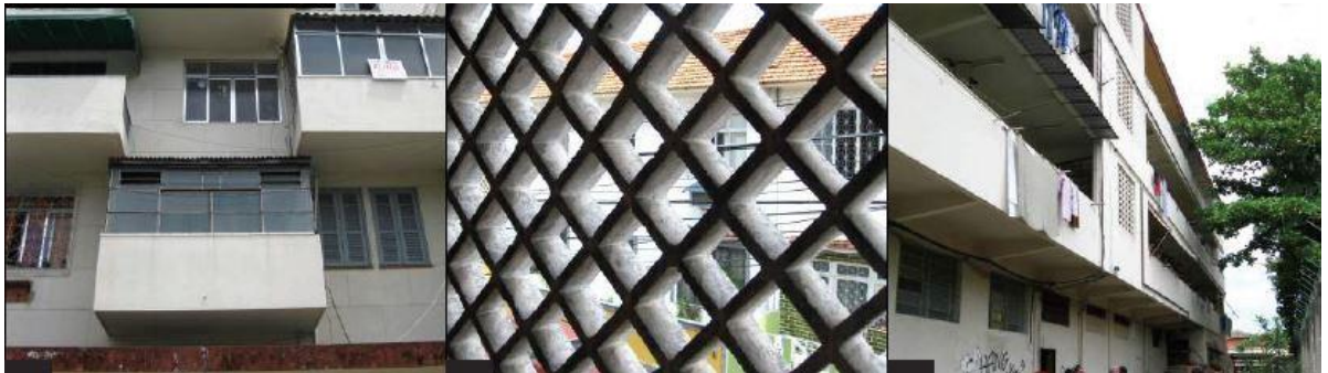
Figura 16 - Jogo de volumes e uso de elementos vazados (cobogós) para ventilação e sombreamento. Fonte: TRIGO, 2013
