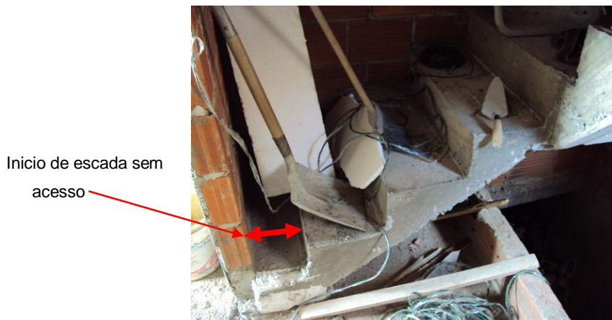
Figura 52 - Escada interna sem patamar de acesso. Fonte: foto da autora, 2015
