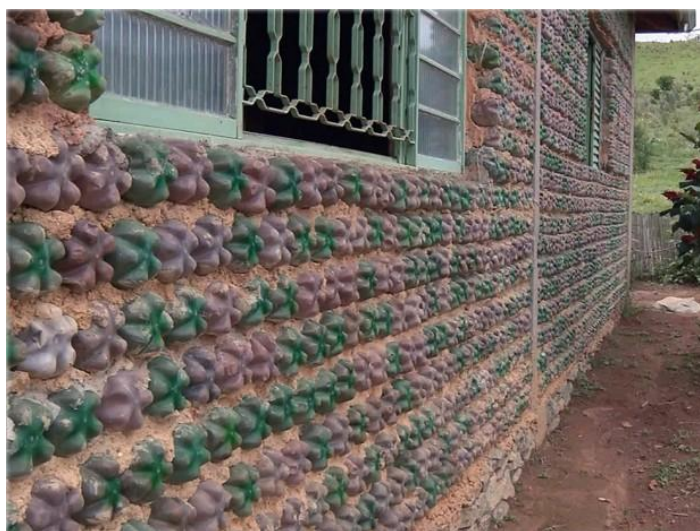
Figura 54 - Casa de garrafas PET executada por pedreiro - MG . Fonte: http://g1.globo.com/mg/sul-de-minas/noticia/2014/12/pedreiro-faz-casa-ecologicamente-correta-com-garrafas-pet-em-mg.html Acessado em 20/maio/2016
