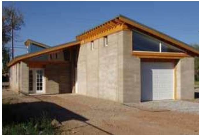
Figura 47 - Casa de terra crua. Arquiteto David Easton. Paredes monolíticas com uso de mangueira de alta pressão.
