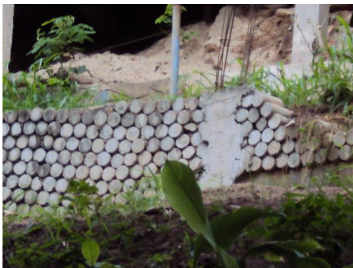
Figura 56 - Contenção executada com corpo de prova de concreto.
