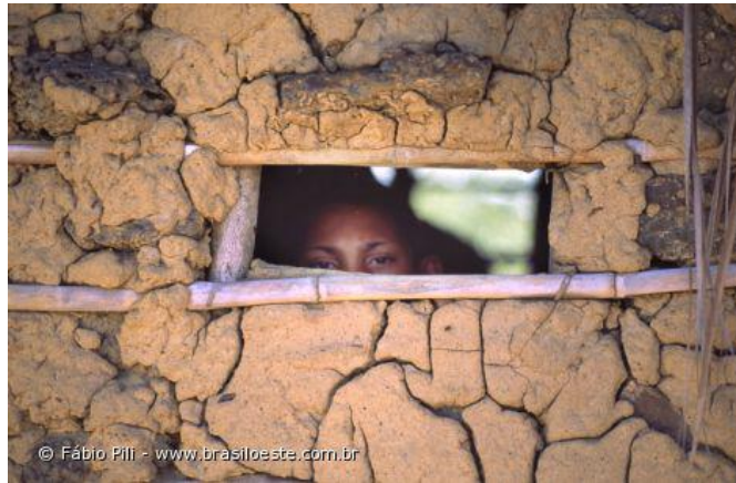
Figura 41 - Casa de pau a pique sem reboco. Exemplo de má execução da técnica. Jalapão – TO. Fonte: http://www.brasiloeste.com.br/ Acesso em 04maio2016
