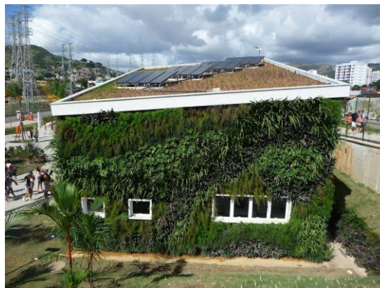
Fig. 25 – Centro de Educação Ambiental do Parque Madureira
