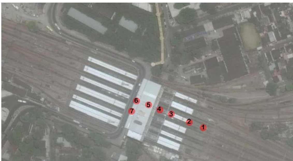
Figura 32. Estação de trem de Deodoro. Fonte: Google Earth, 2016.
