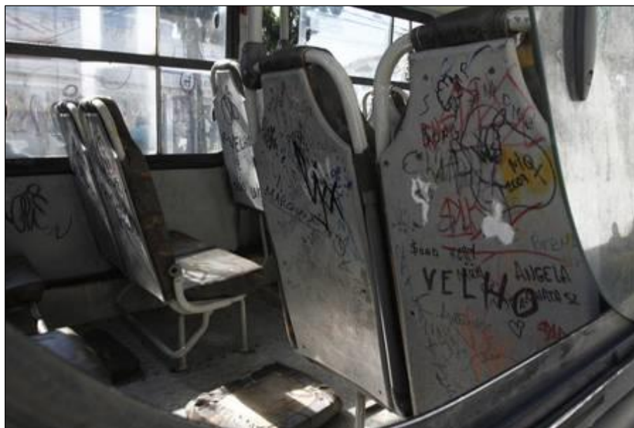
Figura 5: Má conservação dos ônibus no Rio de Janeiro – assentos quebrados e pichados. Fonte: http://extra.globo.com/ . Acesso em Agosto de 2016.
