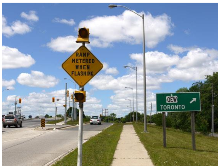
Figura 21: semáforo de tempo variável (ramp metering) na cidade de Hamilton, Canadá. Fonte: www.hamilton.ca . Acesso em Fevereiro de 2016.
