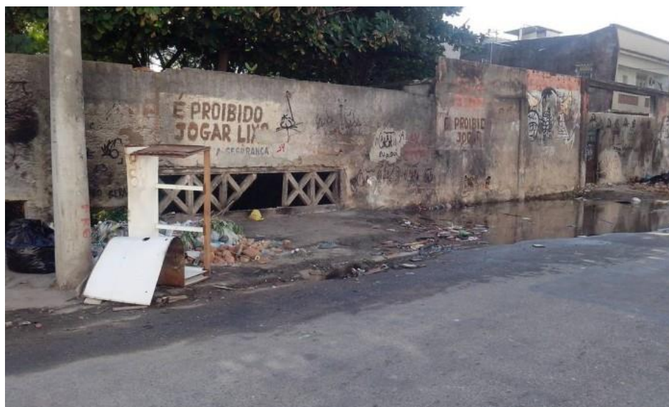
Figura 15: Má conservação da calçada em Piedade, cidade do Rio de Janeiro. Fonte: oglobo.globo.com. Acesso em Setembro de 2016.
