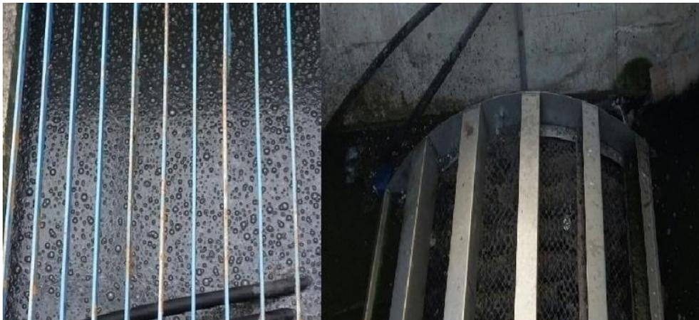
O tratamento terciário é realizado pela inserção de cloro para desinfecção do efluente gerado no sistema biológico. Esse processo ocorre em um tanque com quatro chicanas.
