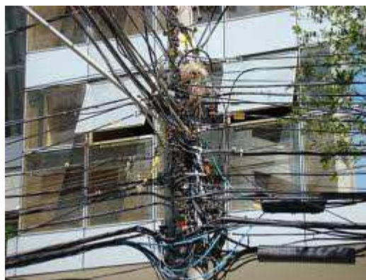
Fig 94 - Excesso de fiação aérea
