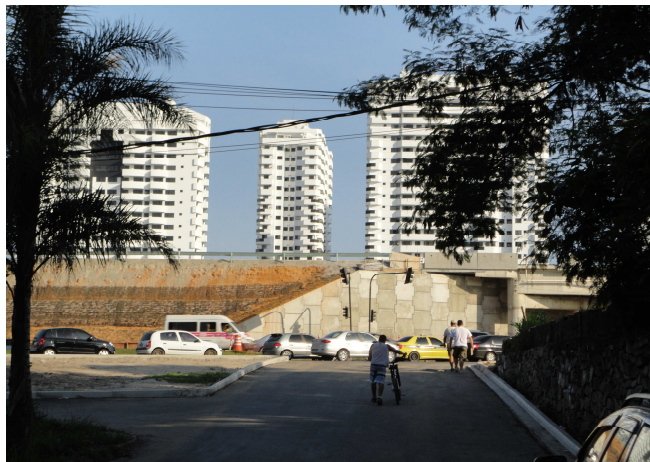
Foto 1 - Interseção atual em viaduto da Av. das Américas com a Av. Salvador Allende
