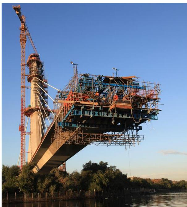
Figura 5-11 – Treliça de lançamento utilizada na Ponte do Saber.
