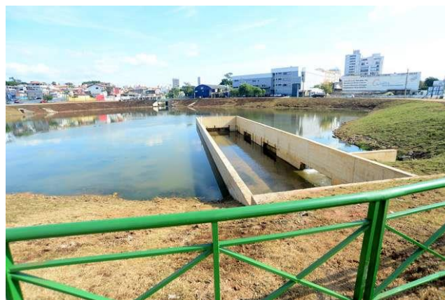
Figura 12 – Reservatórios de detenção
