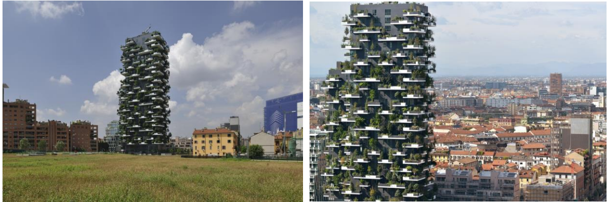
Figura 25 – O empreendimento Bosco Verticale , Milão, Itália
