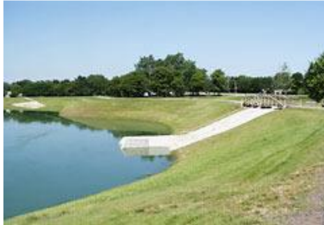
Figura 11 – Reservatório de retenção
