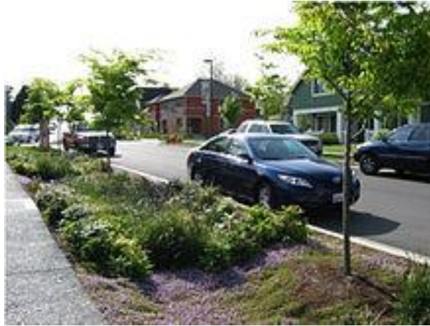
Figura 9 – valas de infiltração
