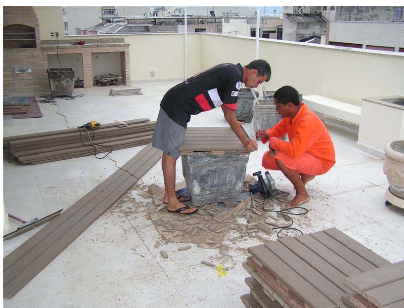
Figura 18 – Ecoproduto Madeira Plástica: Cortes e montagem dos módulos feitos no local (Fotografia: Othon de Castro, 2010)
