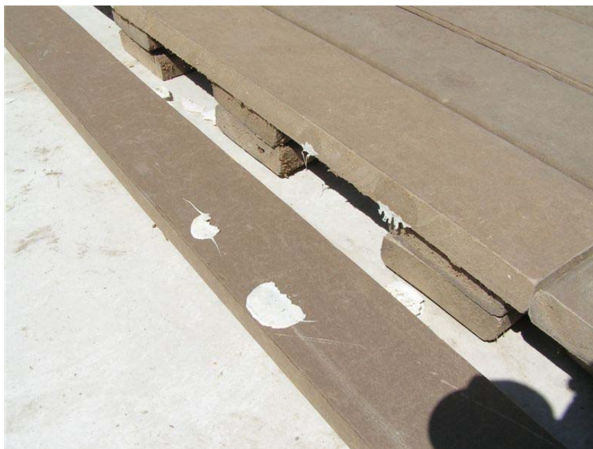
Figura 23 – Ecoproduto Madeira Plástica: Cola utilizada na montagem mostrou-se inapropriada (Fotografia: Othon de Castro, 2010)
