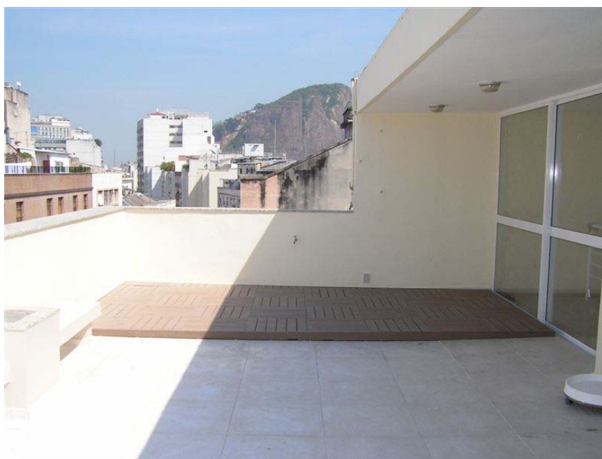
Figura 21 – Ecoproduto Madeira Plástica: Instalação do deck concluída (Fotografia: Othon de Castro, 2010)
