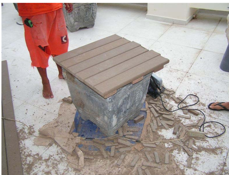
Figura 19 – Ecoproduto Madeira Plástica: Aparas decorrentes da montagem dos módulos (Fotografia: Othon de Castro, 2010)
