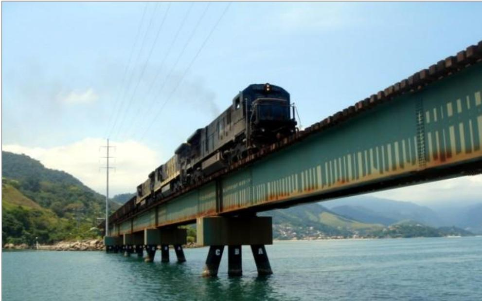
Figura 55 - Vão tipo da ponte ferroviária da Ilha Guaíba, fotografado em 2012
