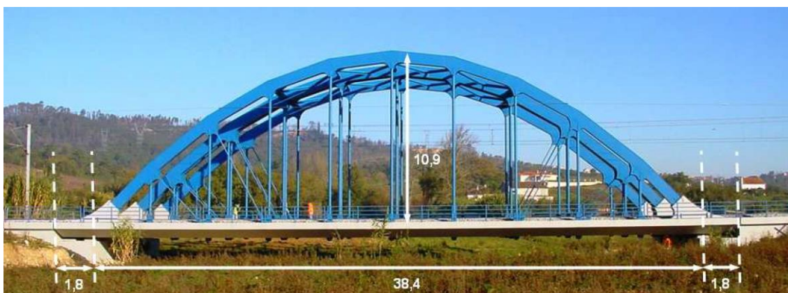
Figura 1-4 – Vista lateral da ponte de São Lourenço (RIBEIRO, 2012)
