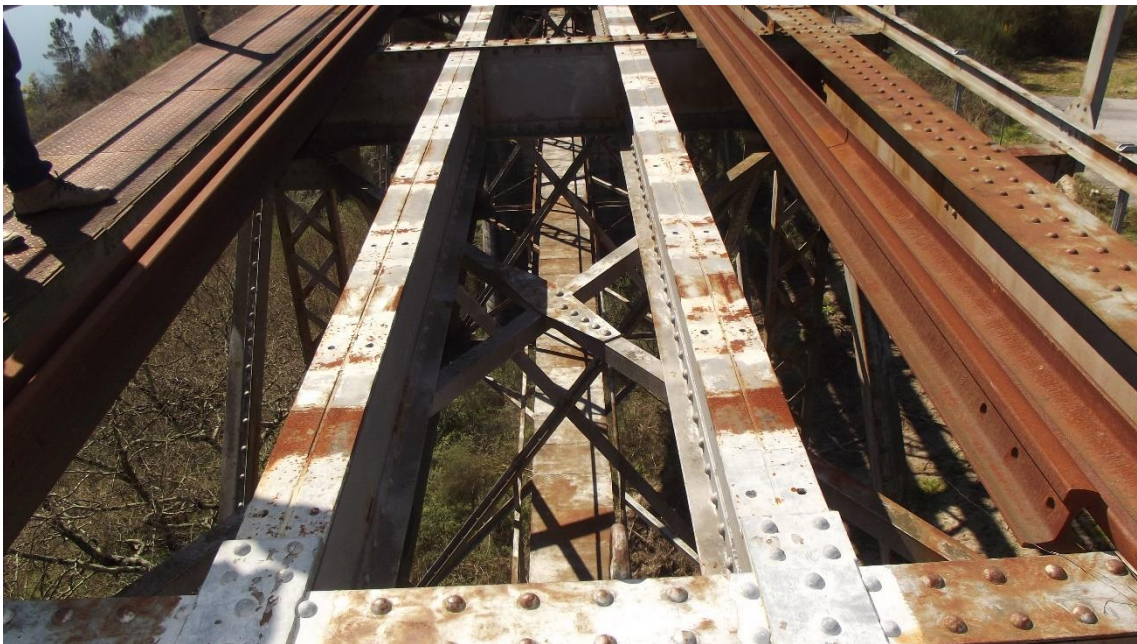
Figura 2-11 – Vista do banzo superior
