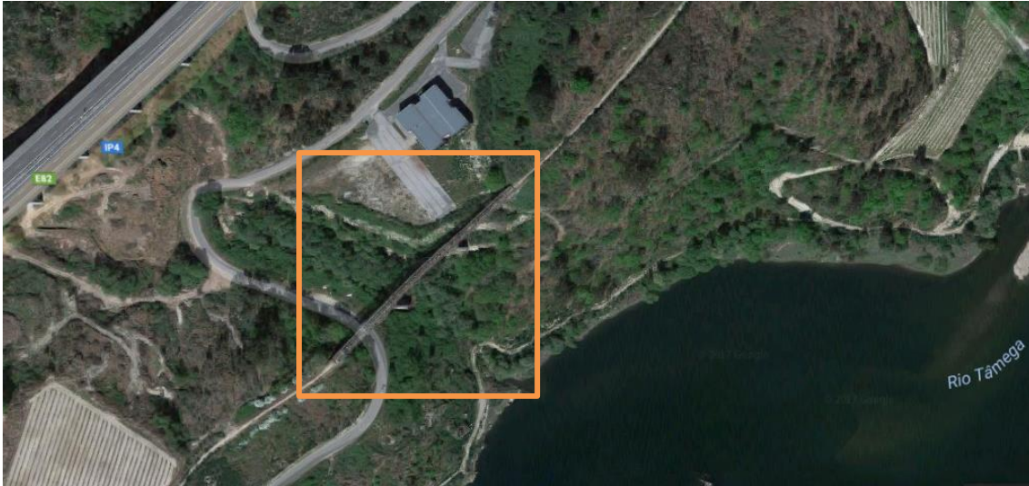
Figura 2-3 – Vista de satélite da Ponte de Baía
