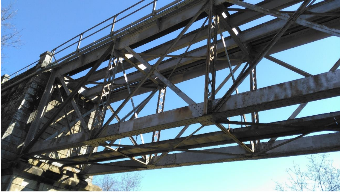
Figura 2-10 – Vista inferior na região do encontro do lado de Amarante
