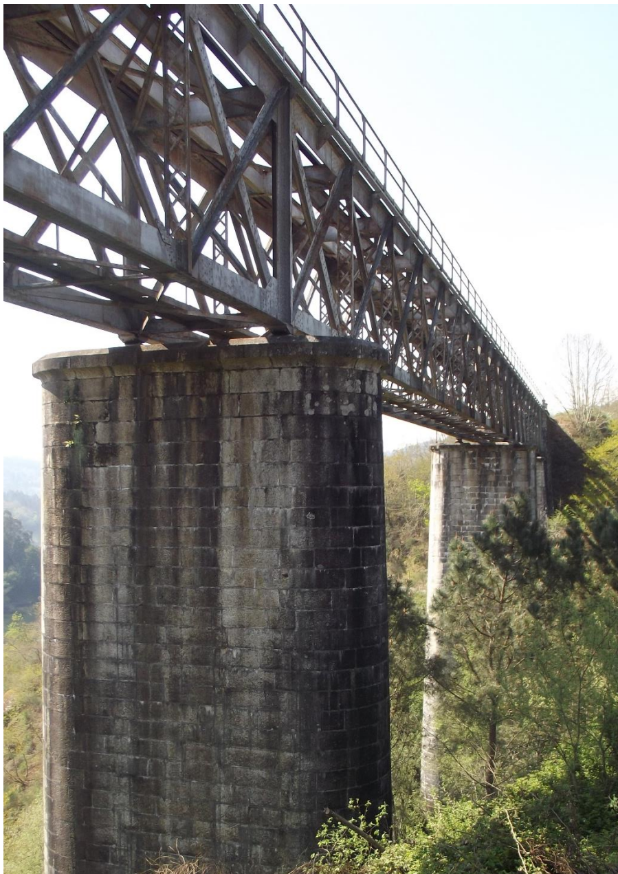
Figura 2-9 – Detalhes do tramo central e pilares
