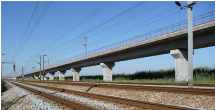
Figura 1-7 – Vista lateral do viaduto ferroviário de Alverca (MALVEIRO, 2013)
