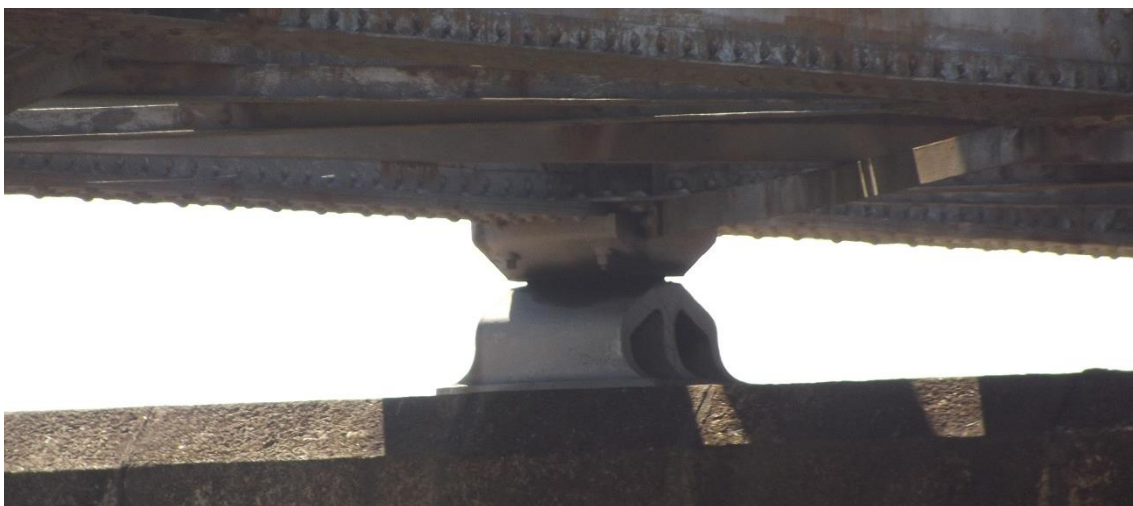
Figura 2-8 – Detalhe do aparelho de apoio tipo B
