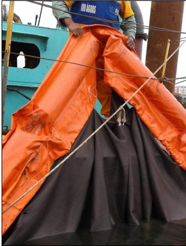
Figura 41a - Cordão flutuante com manta geotêxtil em 24/05/2016. Fonte: Foto cedida pela CMA da SMAC em 2017.
