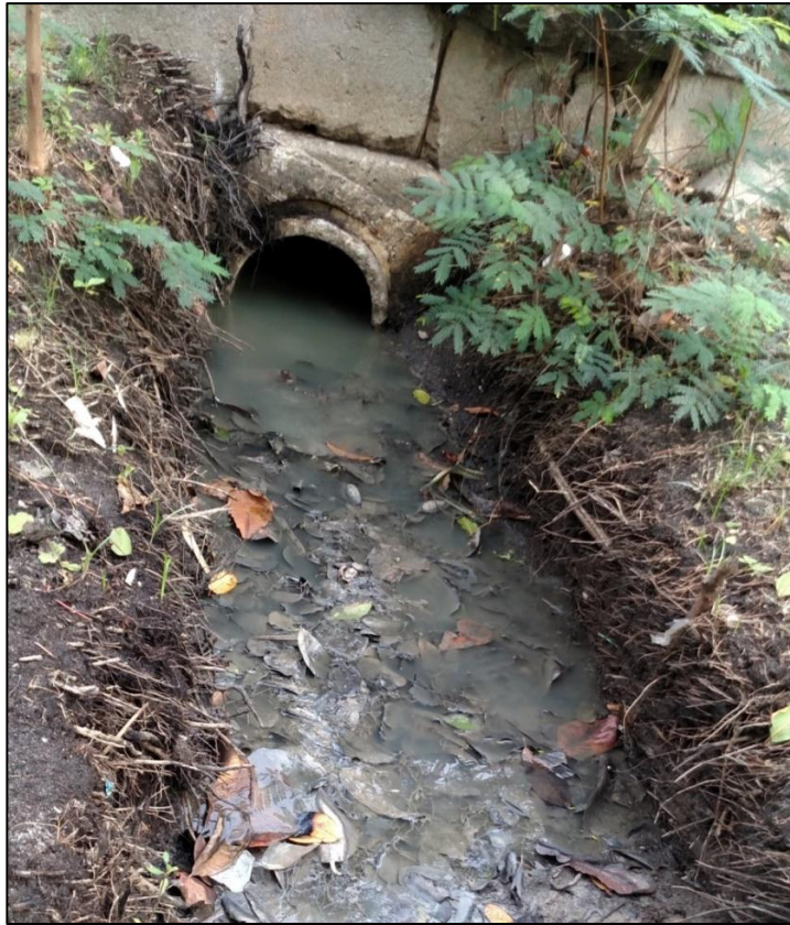
Figura 34 - Saída 20A com características de esgoto no dia 07/07/2015. Fonte: Foto cedida pela CMA da SMAC em 2017.
