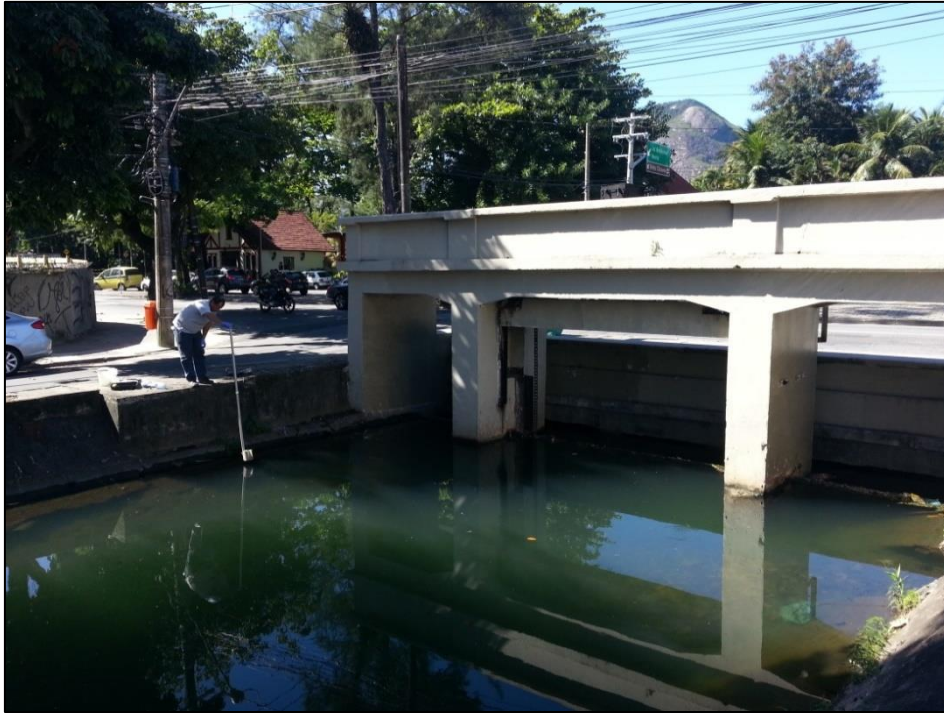
Figura 4 - Canal General Garzon na altura da comporta. Fonte: Elaboração própria, 2016.
