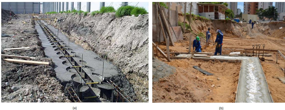
Figura 2-6: (a)-Mureta guia e formas metálicas (MEIRELES E MARTINS, 2006), (b)- Mureta guia e formas de EPS (Fonte: Foto da construção do edifício Sopa Patino – Fortaleza, Ceará).
