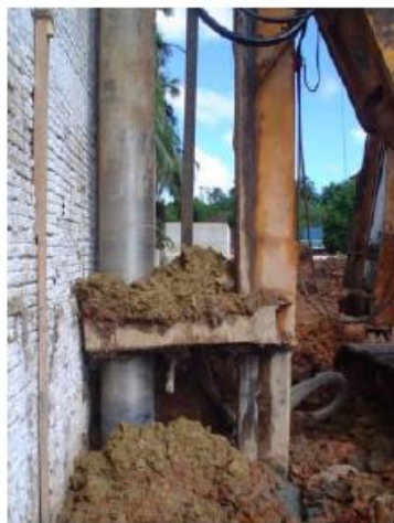
Figura 2-10: Execução de estaca junto à divisa (FLEURY, 2012, apud SANGLARD, 2014).
