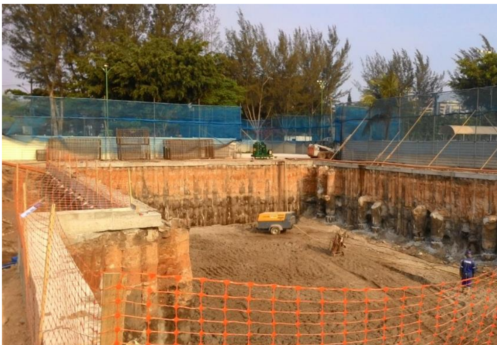
Figura 4-20: Foto da obra - Região da seção S-05.
