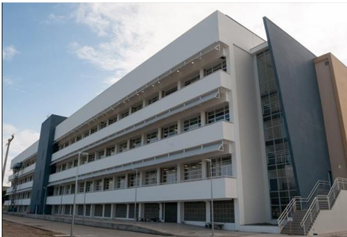
Figura 10 – Prédio do Laboratório de Apoio ao Desenvolvimento Tecnológico.
