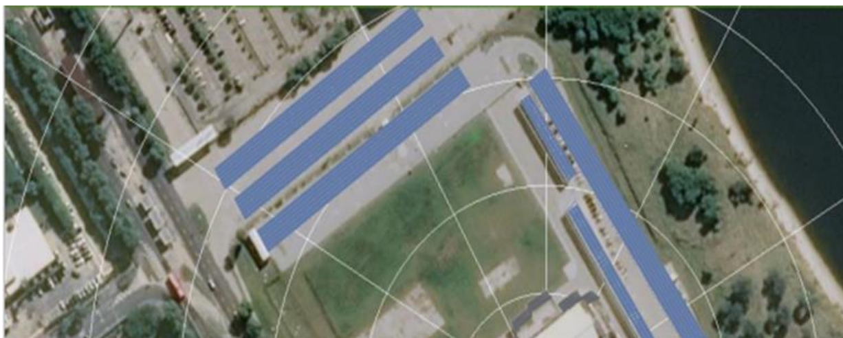
Figura 29 – Imagem dos painéis instalados nas áreas 1, 2, 4 e 5.
