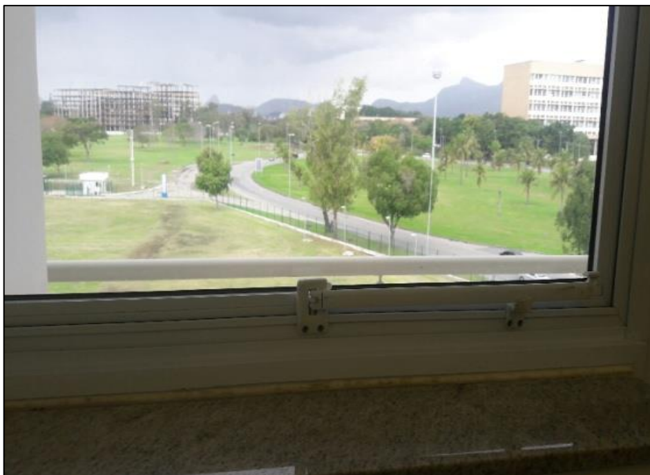
Figura 11 – Fotografia da esquadria da janela.
