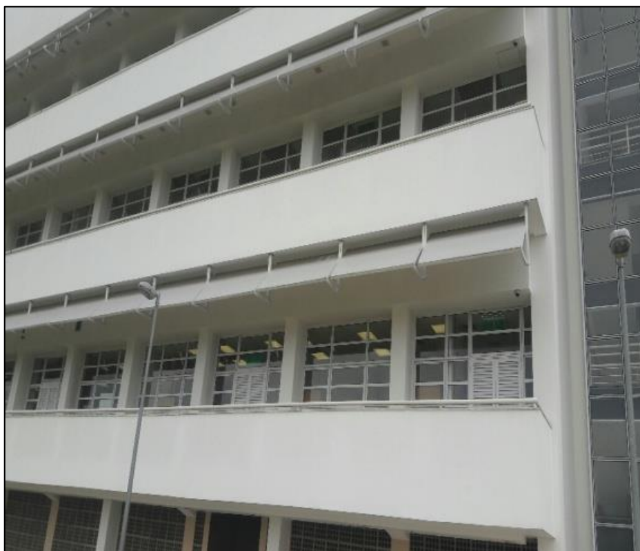
Figura 12 – Fotografia das janelas com brises.
