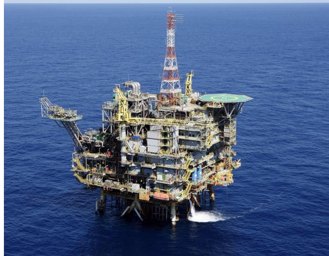
Figura 5 Plataforma fixa de Mexilhão operando na Bacia de Santos Fonte: PETROBRAS, 2017.
