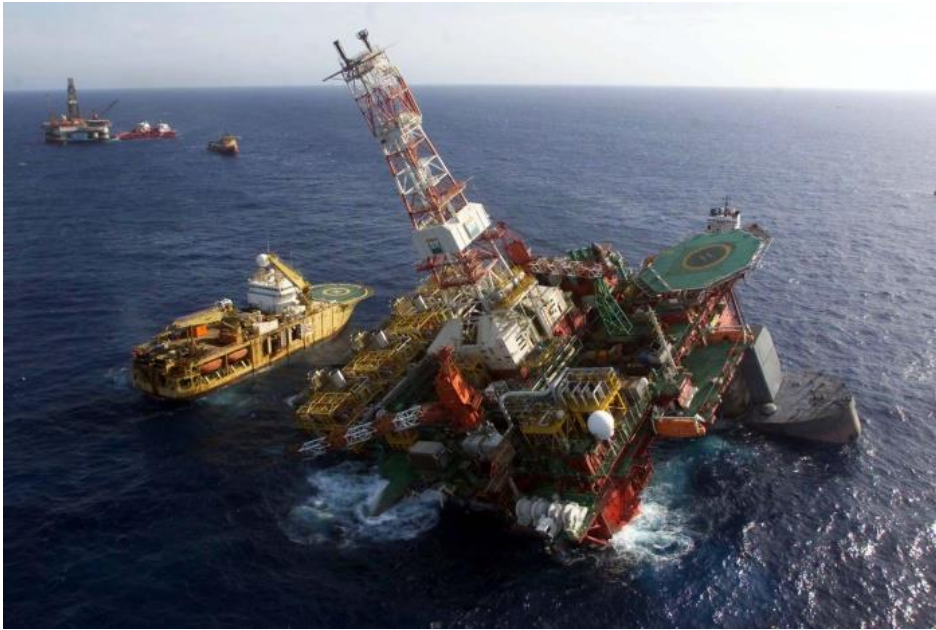
Figura 3: Adernamento da plataforma P-36. Fonte: R7 (2012).
