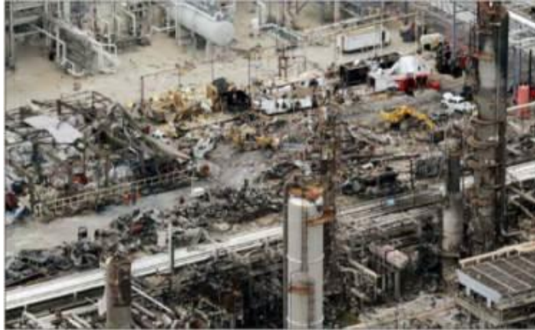
Figura 15 – Acidente de Texas City Fonte: CSB (2005)
