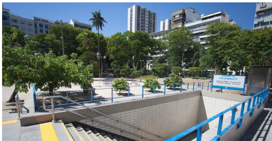
Figura 5 - Estação de metrô Afonso Pena, Local Station
