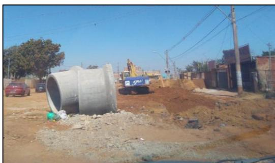
Figura 33: Construção da rede de águas pluviais.
