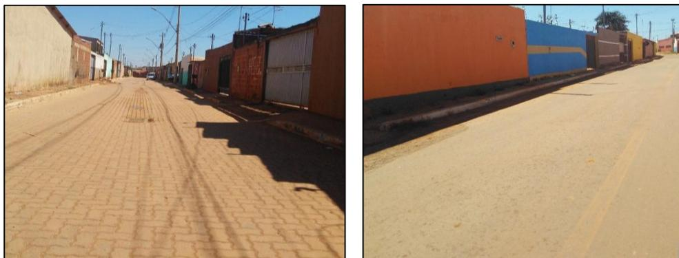
Figura 35: Pavimentação nas vias locais (à esquerda) e nas vias principais (à direita)
