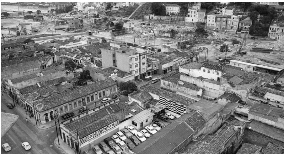
Figura 15 - Demolição de casas no Catumbi, para implantação da Linha Lilás
