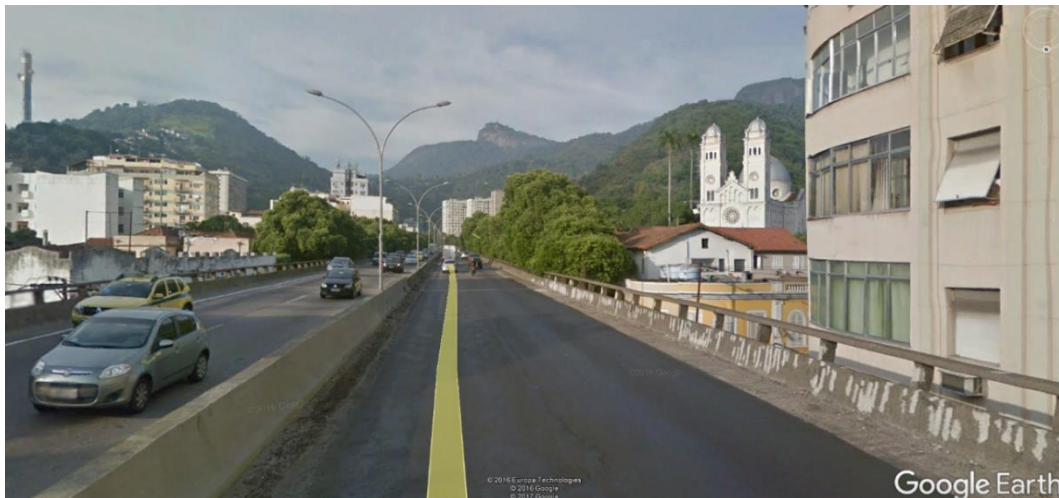
Figura 17 - Viaduto sobre a Avenida Paulo de Frontin com Igreja de São Pedro ao fundo e edificação próxima ao viaduto.
