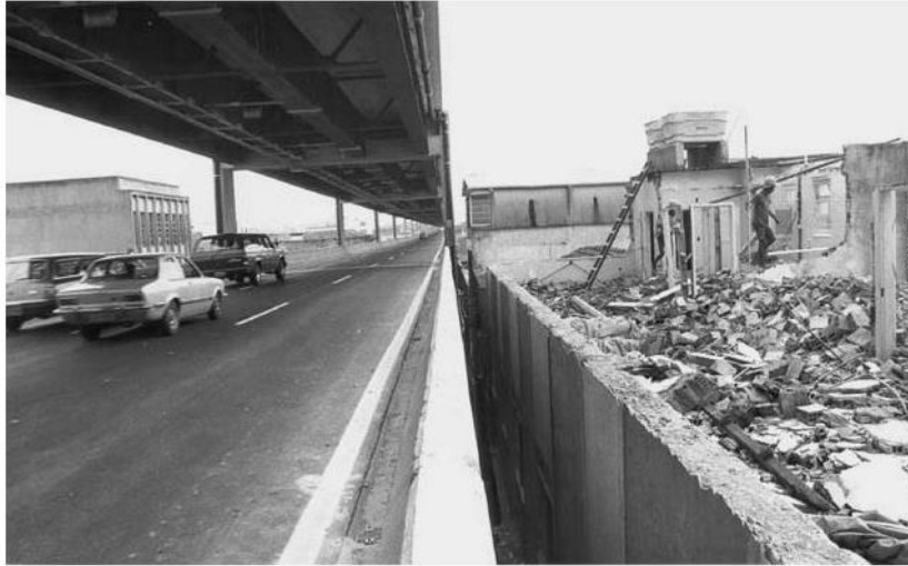
Figura 20 - Demolições na Rua Bela em São Cristóvão para a Construção da Linha Vermelha
