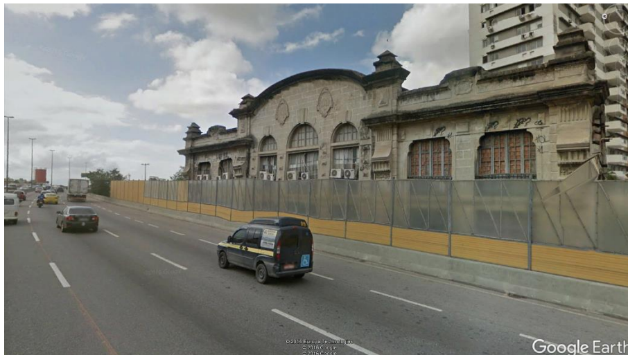
Figura 22 - Linha Amarela em trecho próximo ao Colégio Estadual Olinto da Gama Botelho
