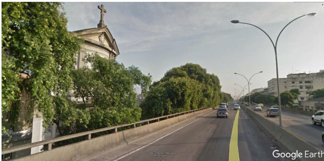
Figura 18 – Imagem do viaduto Engº Freyssinet em frente a Paróquia Nossa Senhora das Dores.
