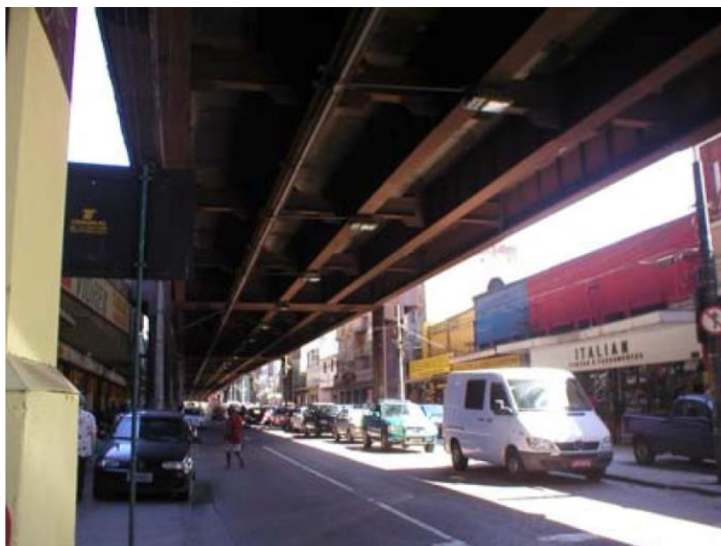
Figura 21 - Viaduto da Linha Vermelha sobre a Rua Figueira de Melo
