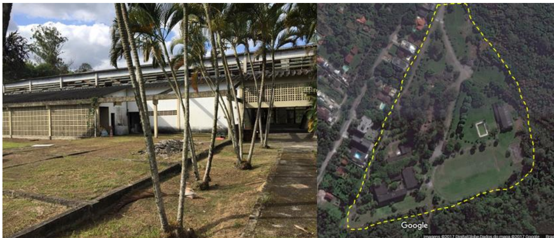
Figura 38 - Instalação do Antigo Colégio Cidade e fotografia aérea do espaço da escola.
