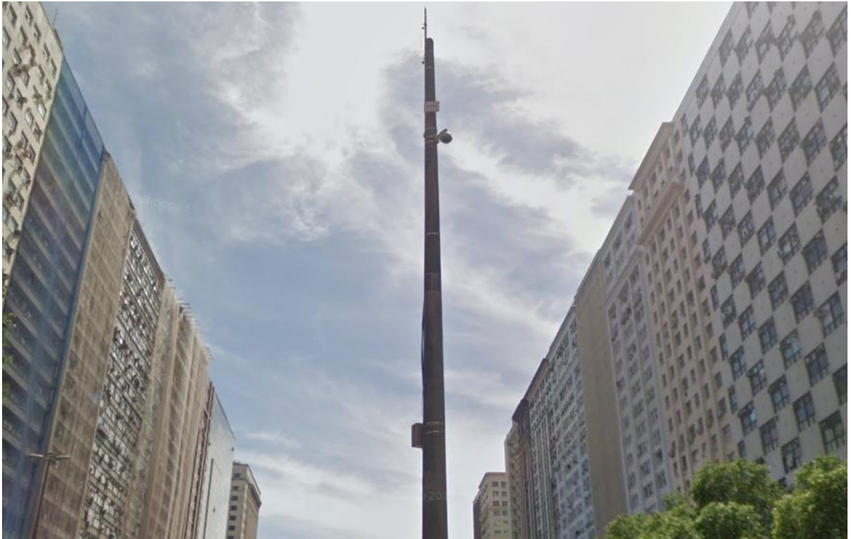
Fig. 8 – Câmera de vigilância do Projeto instalada em poste
