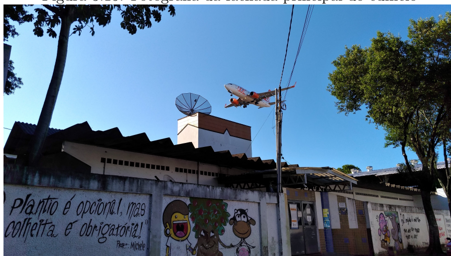
Figura 3.15: Fotografia da fachada principal do edifício
