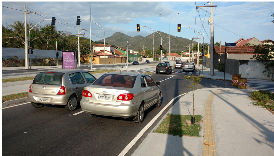
Figura 5.7: Faixas de Rolamento Estreitas.
