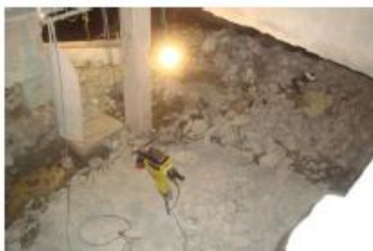
Figura 6 – Concreto – Resíduo de demolição Vidal, 2014
