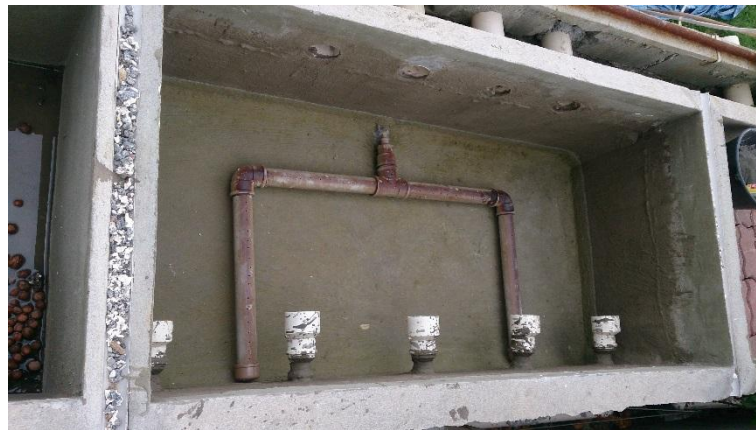
Figura 9 – Tubulação de drenagem (2015)
