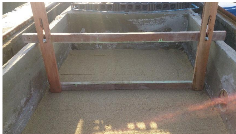
Figura 15 – Camada de areia de regularização para assentamento das placas (2015)
