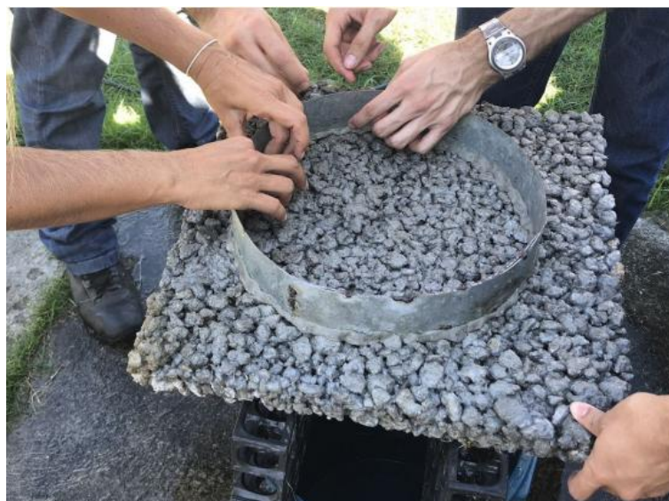
Figura 32 – Preenchimento de possíveis vazios, 2018.
