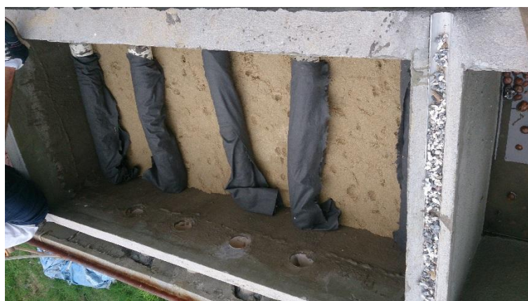
Figura 11 – Disposição das tubulações cobertas com bidin após 1ª camada de areia (2015)
