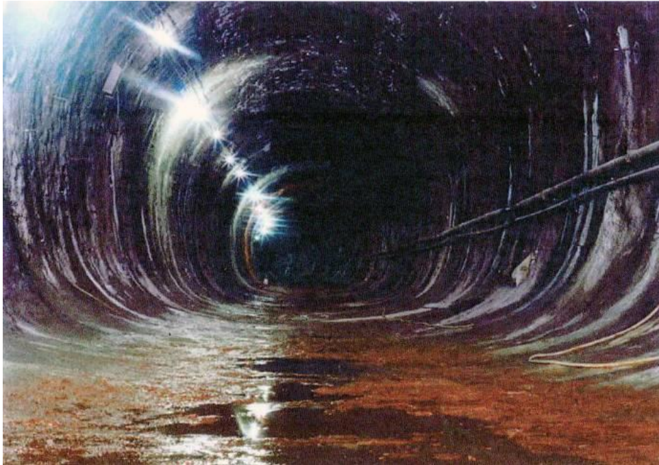
Figura 30 – Foto interna do Túnel Guandu-Macacos.
