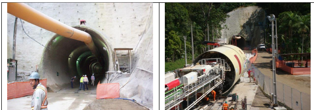
Figura 47 – Túnel Gastau em construção
