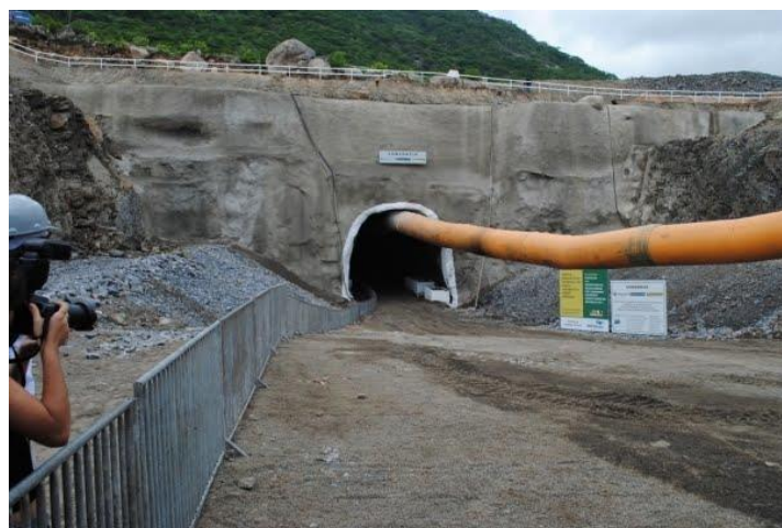
Figura 34 – Túnel Cuncas I em construção – entrada.
