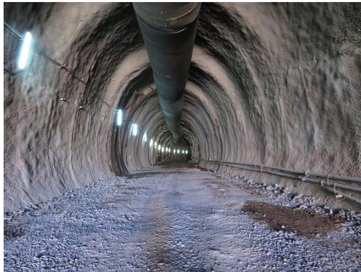
Figura 33 – Túnel Cuncas I em construção – parte interna.
