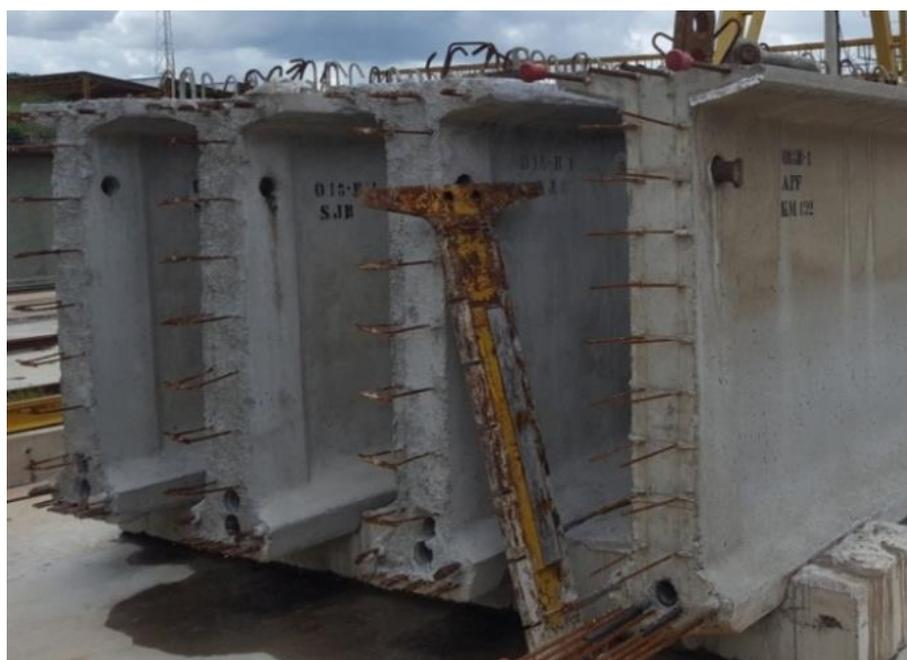
Figura 45- Trecho central da viga pré-fabricada com esperas da armadura.
