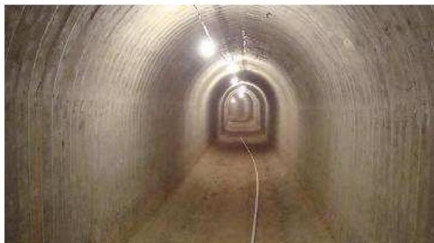
**Figura 26 - Galeria de drenagem (túnel bala) sob Anel Rodoviário (obra concluída) – Belo Horizonte**
