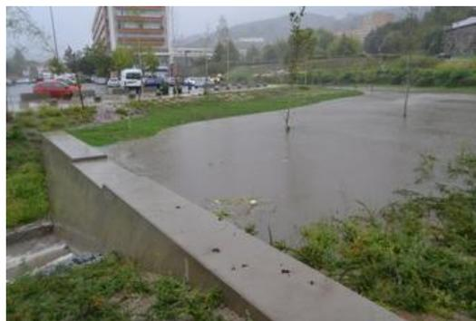
Figura 8 - Bacia de detenção *in line* após ocorrência de chuva
