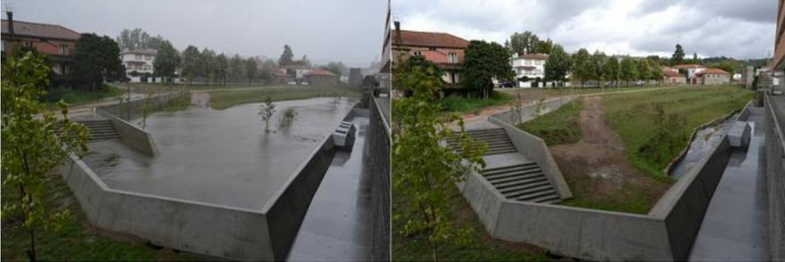
**Figura 43 - Bacia de detenção *in line* construída em Guimarães - Portugal**
