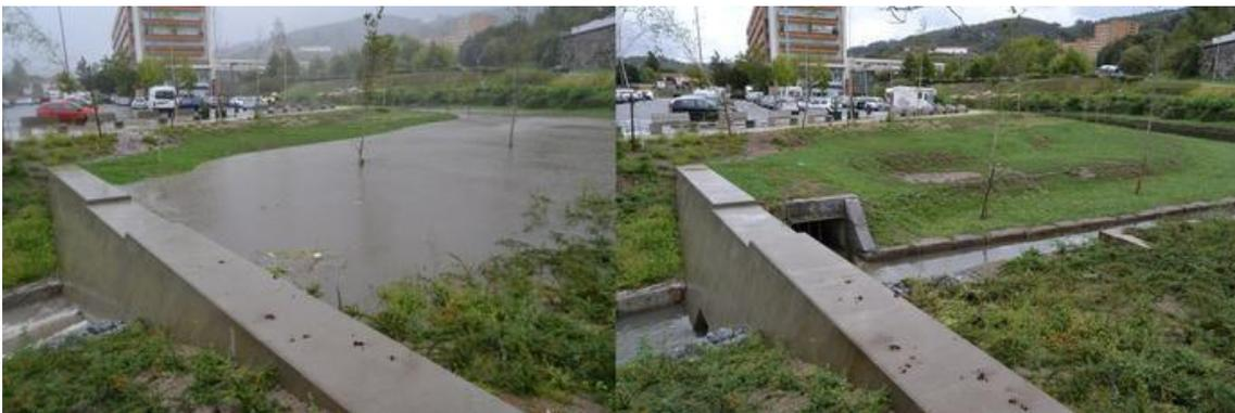
Figura 42- Bacia de detenção *in line* construída no projeto de requalificação do Parque das Hortas – Guimarães - Portugal
