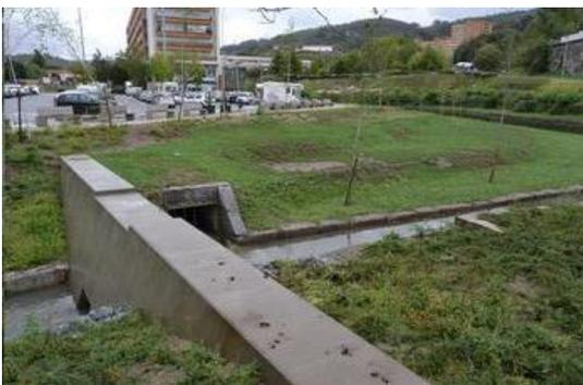
Figura 7 - Bacia de detenção *in line* em período seco.
