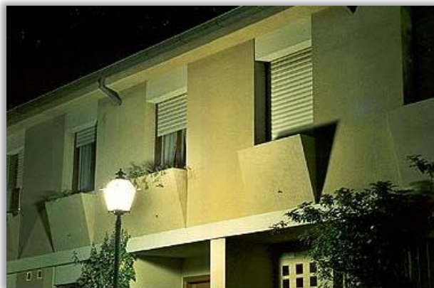
Figura 22 Luz Intrusiva sobre a Fachada de uma Edificação
